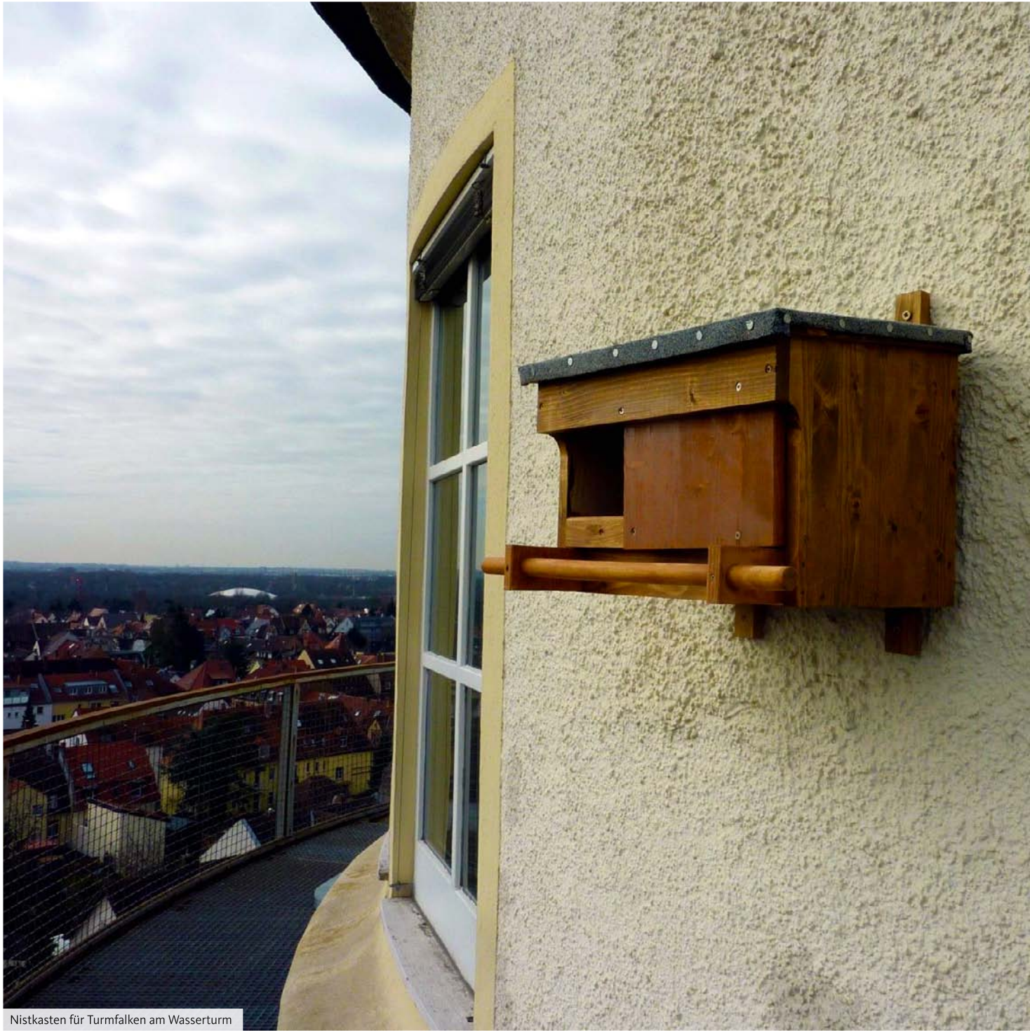
Nistkasten für Turmfalken am Wasserturm
