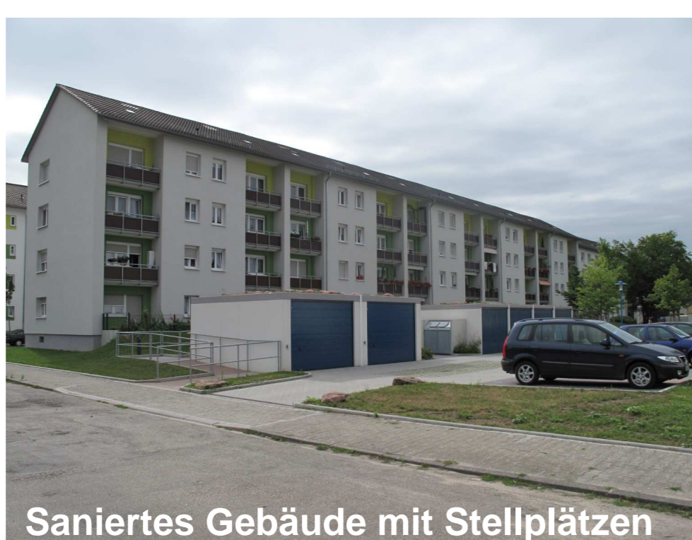
Saniertes Gebäude mit Stellplätzen
