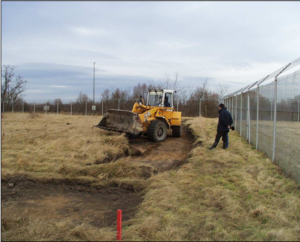
Abb. 16: Abschieben von Oberboden im Frühjahr 2001; Foto: D. Nährig
