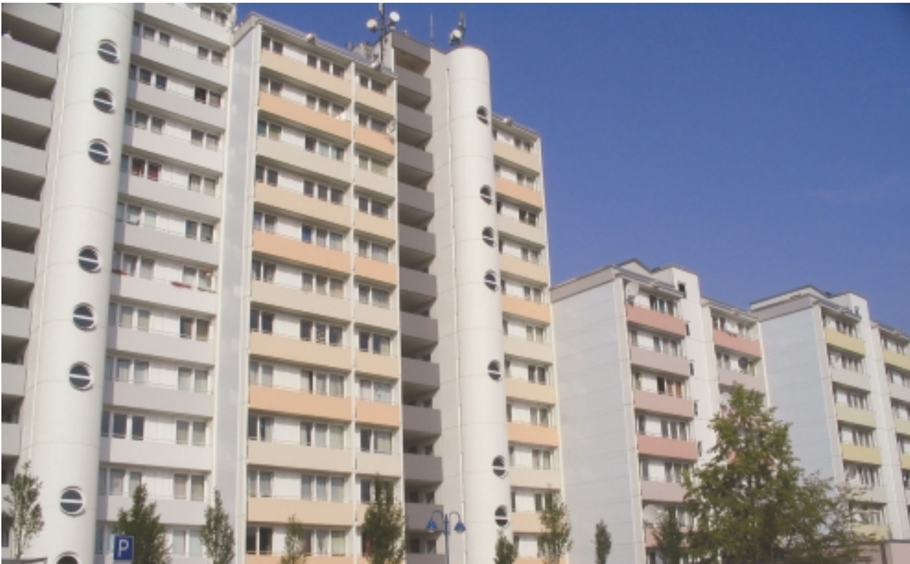
Die Durlacher Straße mit neuer Fassadengestaltung
