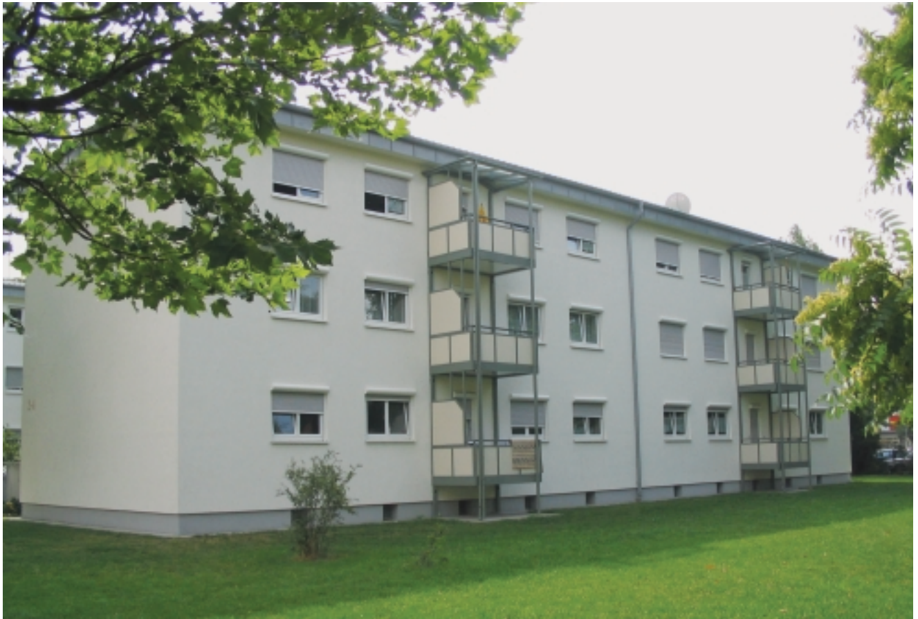
... und Rückansicht mit neuen Balkonen
