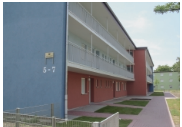
Saniertes Gemeinwesenzentrum Frohe Zuversicht 5 – 7
