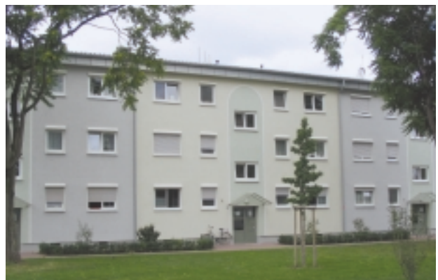
Bereits modernisierte Gebäude, Vorderansicht ...
