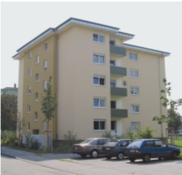
Sog. „Punkthaus“ nach der Modernisierung
