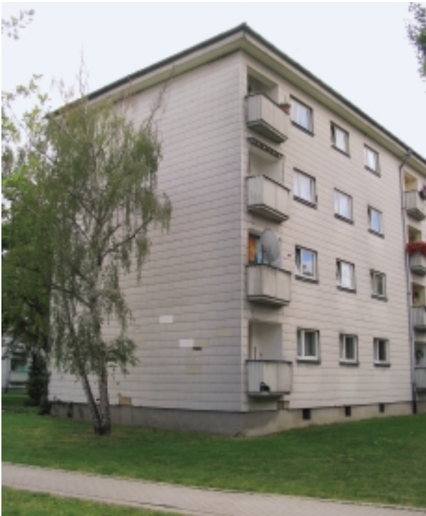
Alter „ECA-Bau“ aus den Nachkriegsjahren
