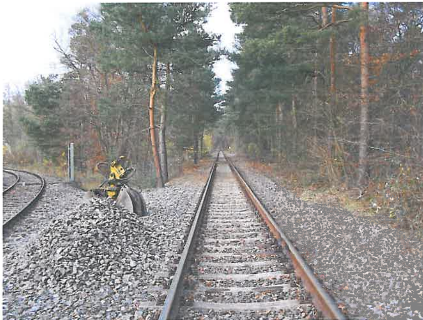
Abbildung 3.2-9. Untersuchungsfläche 8, Blick nach Norden entlang der noch genutzten Gleistrasse.
