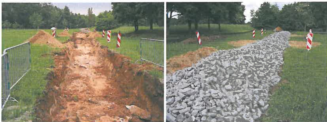
Abbildung 4.1-1. Graben und Sandschüttungen zu Beginn der Maßnahmenumsetzung (links), Steinriegel und sandige Offenbodenbereiche nach Fertigstellung des Ersatzhabitats (rechts).
