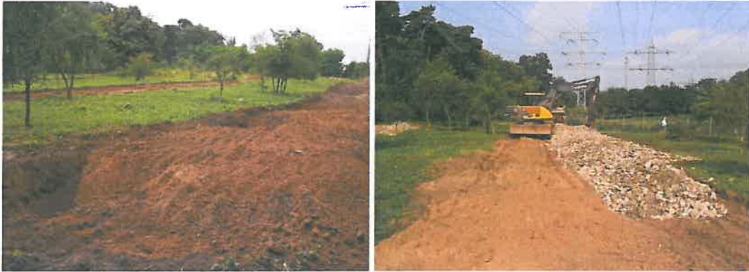
Abbildung 4.1-2. In regelmäßigen Abständen angelegte Gruben und abgeschobener Oberbodenbereich, der als Fahrspur genutzt wurde (links), Steinriegel im Endzustand (rechts).
