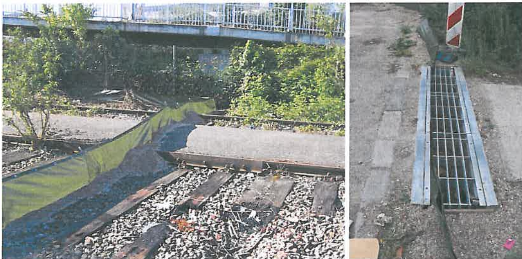
Abbildung 5.1-1. Amphibienschutzzaun (links) und Amphibienstopprinne (rechts).
