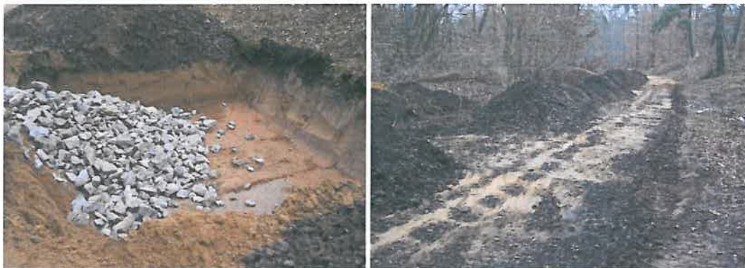
Abbildung 4.1-3. Mit Muschelkalk-Schroppen verfüllte Grube (links), zu Steinriegeln angehäuften Schottermaterial der ehemaligen Gleistrasse (rechts).
