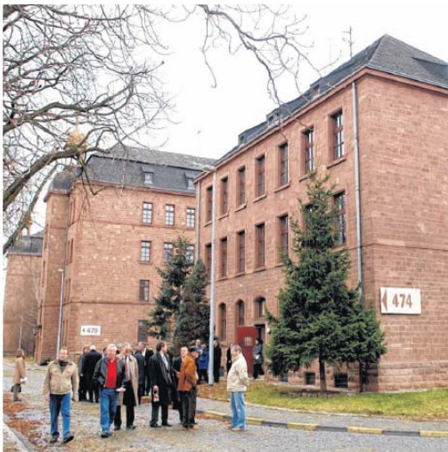
Das „Turley-Bündnis“ plant für Interessierte eine eigene Besichtigung des Geländes in der Neckarstadt mit Informationen und kulturellen Darbietungen.
