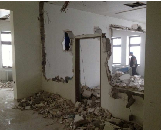
Renovierungsarbeiten auf den Turley-Barracks
