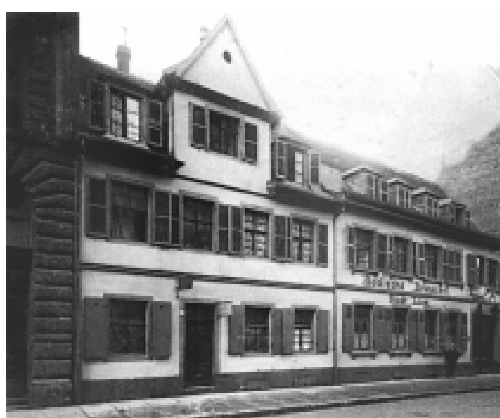
Die Wirtshausstradition in P 2 bleibt auch im 18. Jahrhundert und später ungebrochen. Das Wirtshaus „Stadt Lück“ in P 2, 9, das schon vor 1688 existiert, ist ein zweigeschossiger Bau, dessen Dachausbau Mitte des 19. Jahrhunderts erfolgt. Aufnahme von 1908.
