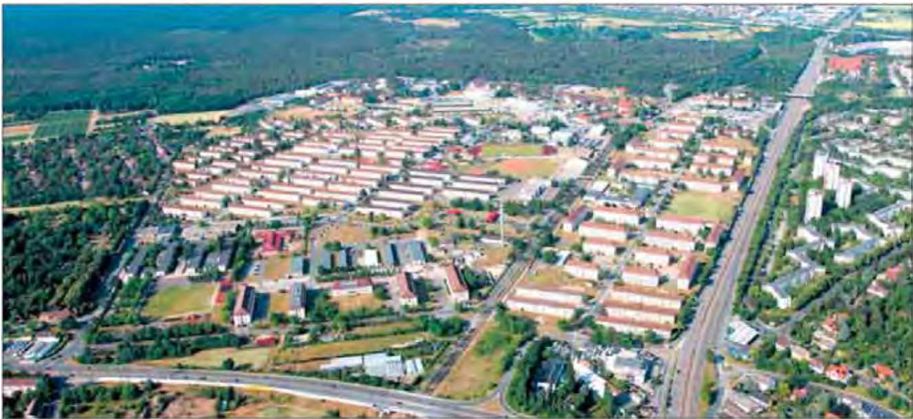
Im Hintergrund liegt der Käferwald, rechts ist die B 44 zu sehen, die zum Viernheimer Autobahnkreuz führt. Mitten durch die Siedlung verläuft die DEG-Linie Mannheim-Weinheim. Im Grün und trotzdem sehr gut verkehrlich angebunden ist das Areal Benjamin-Franklin-Village. Auf 88 Hektar könnten Wohnungen, aber auch etwas Gewerbe entstehen. Foto: Sommer
