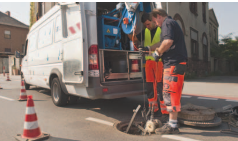
Vorbereitung der Inspektion am Kanalschacht
