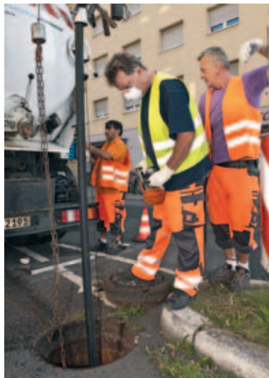
Blick in den geöffneten Schacht: Kanalreinigung mit Hochdruckspüldüse
