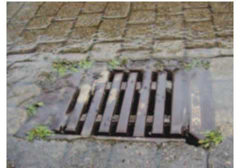
Regeneinlauf mit Rinnengitter (Gully)
