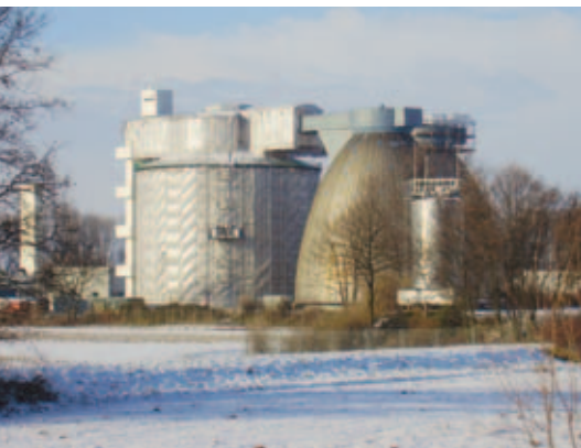
Eingehauster Faulbehälter während der Sanierung im Winter
