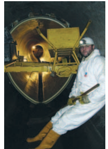
Das eingebaute Kanalrohr im Profil
