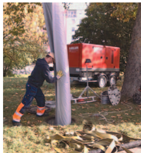
Einbau eines Inliners in der Reichskanzler-Müller-Straße
