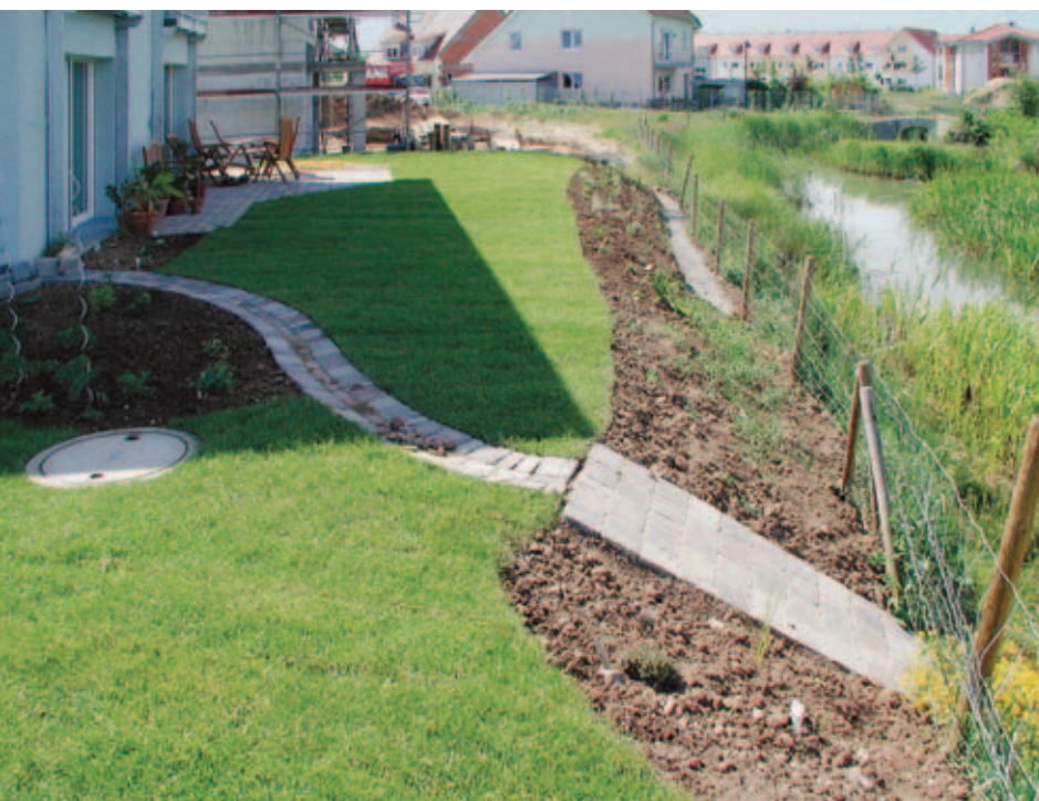
Ableitung des Regenwassers vom Dach über offene Rinnen in den Versickerungsgraben (Lagune in Wallstadt)
