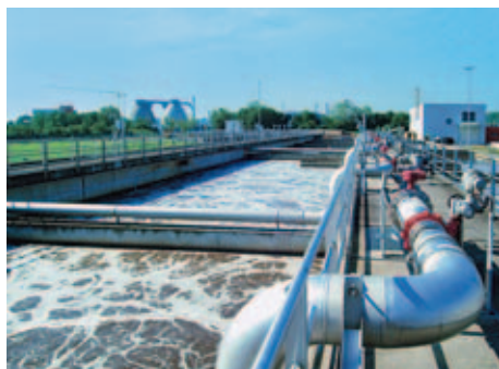
Belebungsbecken der biologischen Reinigungsstufe
