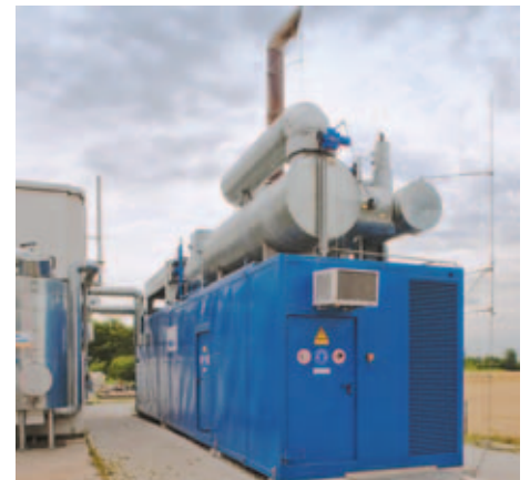
Blockheizkraftwerk in Containerbauweise
