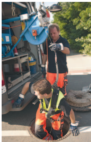
Höhensicherung beim Einstieg in den Schacht
