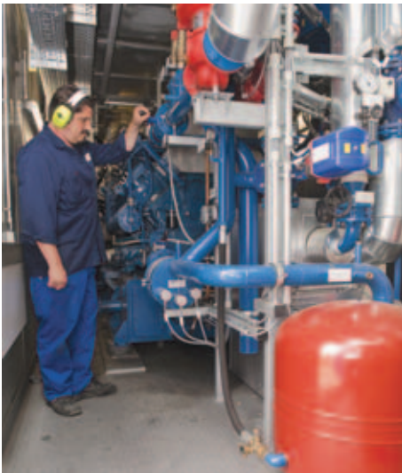
Gasmotor im Container-BHKW
