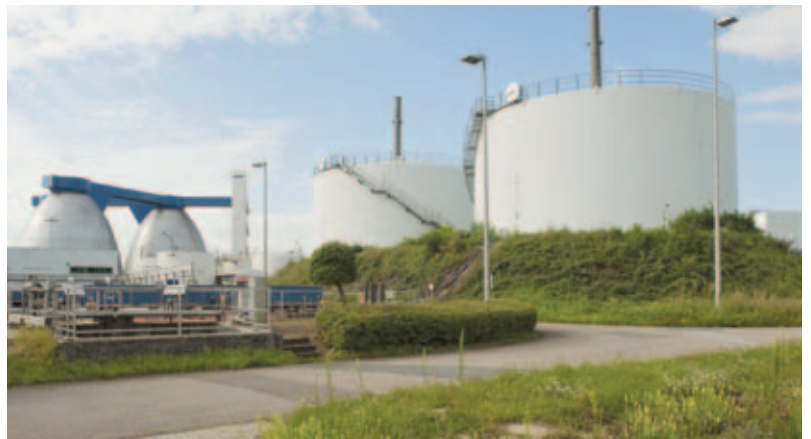
Faultürme und Gastanks
