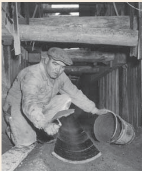
Kanalmaurer bei der Herstellung der Sohlaukleidung 1951
