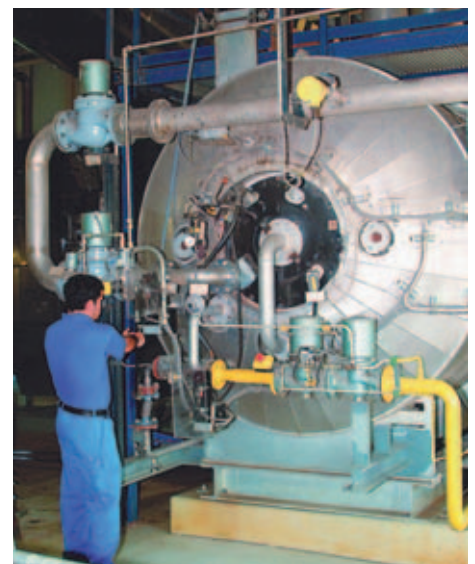
Heißgaserzeuger zur Schlamm-trocknung
