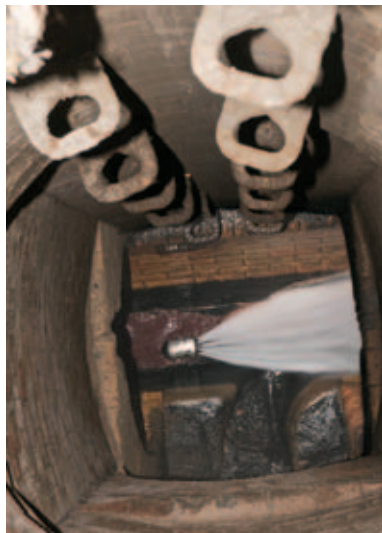
Blick in den geöffneten Schacht: Kanalreinigung mit Hochdruckspüldüse
