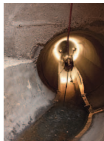
Ferngesteuerte TV-Kamera im Kanal
