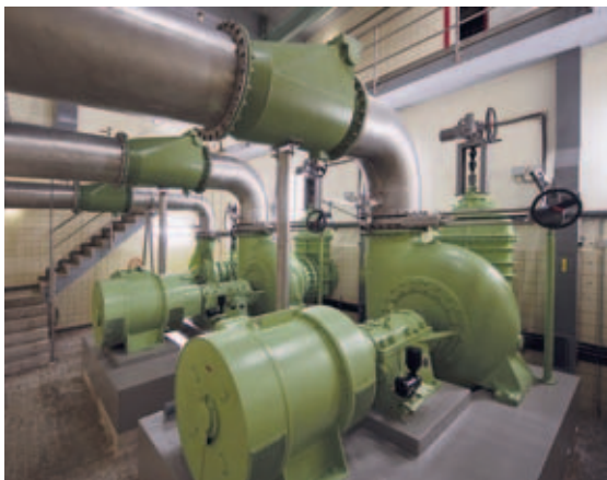
Regenwasserpumpen im Pumpwerk Speyerer Straße
