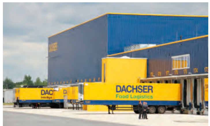
Im Juli 2011 weihte das Logistikunternehmen Dachser sein neues Logistikzentrum ein. / Firmenfoto
