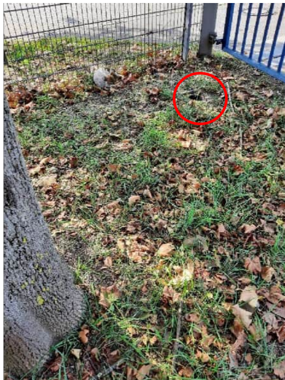
Abbildung 21: kleiner Schacht in ca. 2,5 m Entfernung
