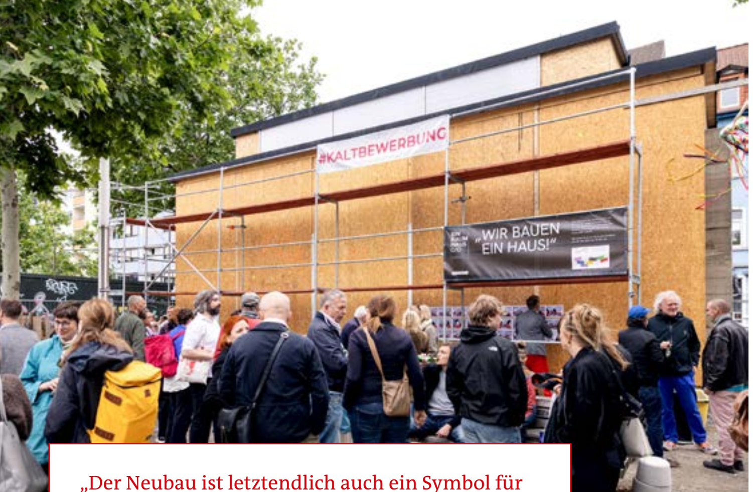
Richtfest: Einraumhaus c/o, / Alter Messplatz
