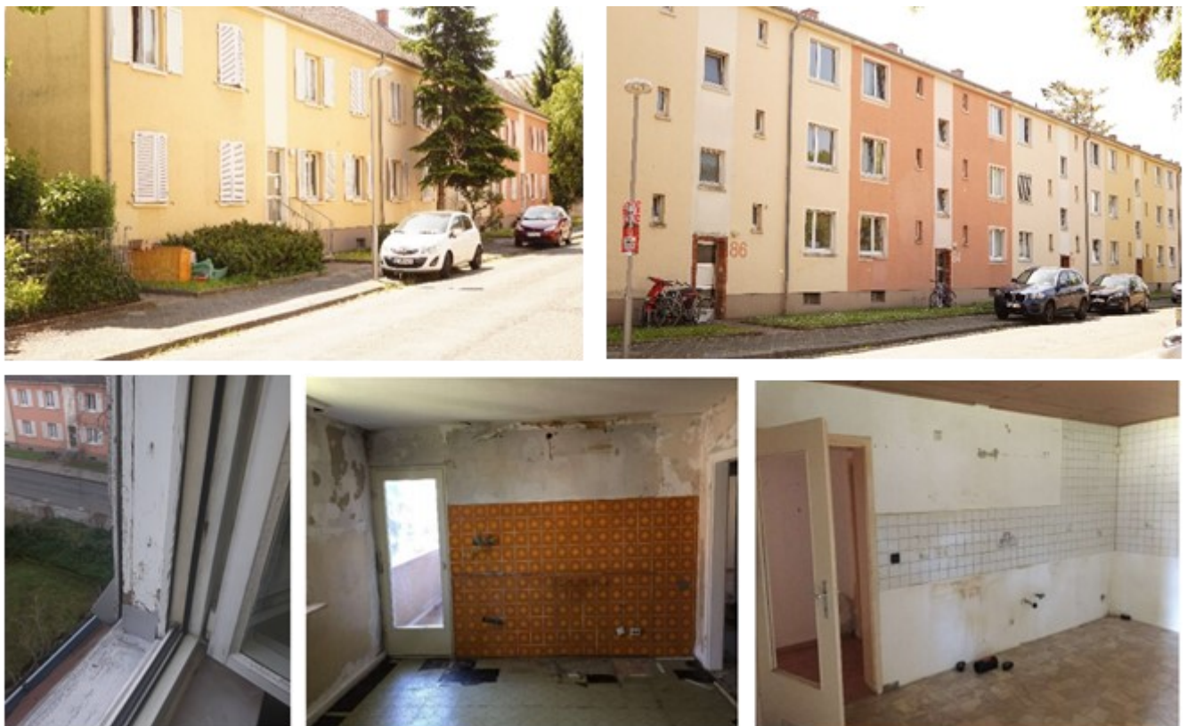
Abb. 9 bis 13: Abbruchgebäude am Habichtplatz
