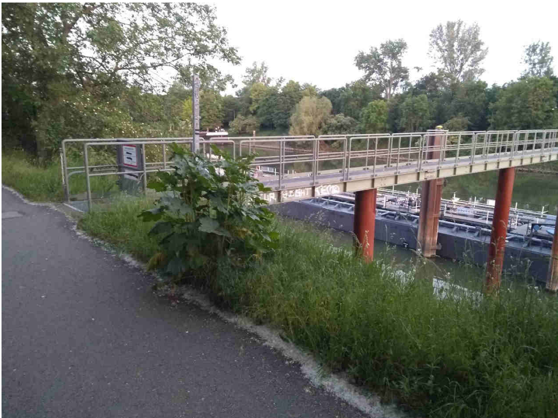
Abb. 13: Blick vom Fuß- und Radweg auf den Neckarkanal.
