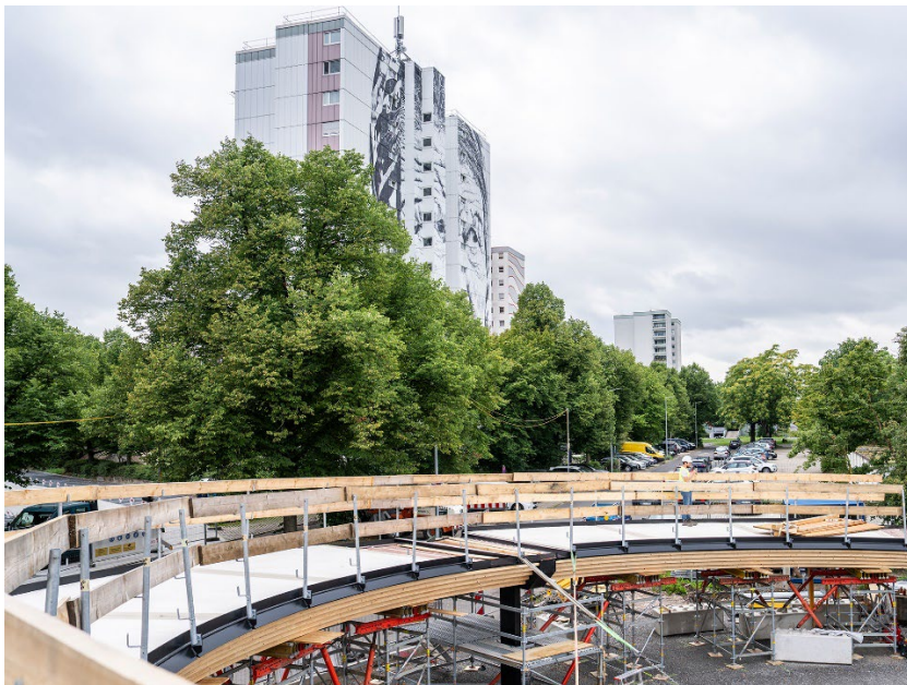
Start Montage FRANKLIN Steg auf der Seite Vogelstang © MWSP / Erkan Sezer
