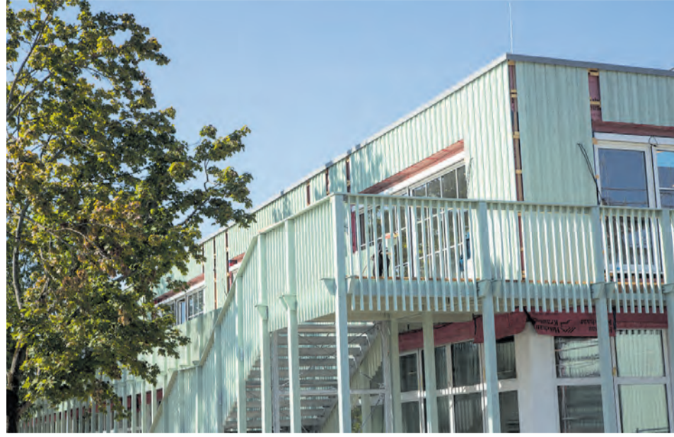
Die Franklinschule wurde in Holzhybridbauweise geplant.
