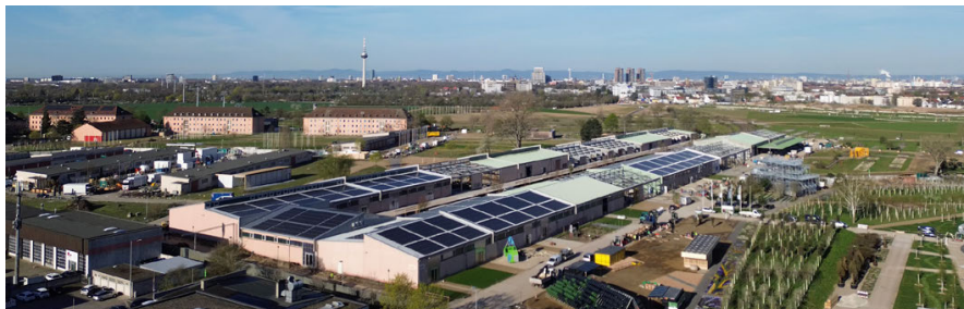
Auf dem Dach der U-Halle sorgt eine von der MVV Energie installierte 6.500 Quadratmeter große Photovoltaik-Anlage für grünen Strom auf der BUGA 23.
