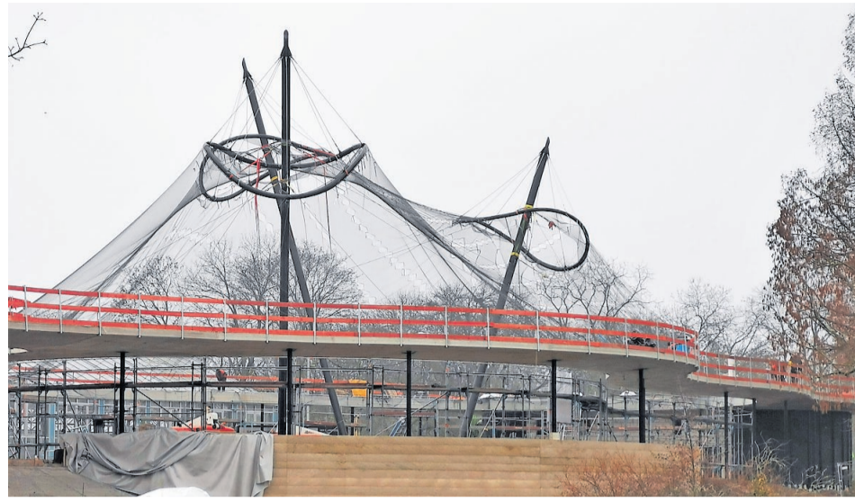
Die begehbare Großvoliere trägt nun ihre imposante und gleichzeitig filigrane Netzkonstruktion.
