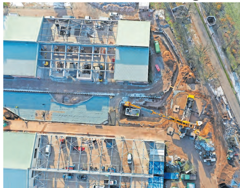
Eine 6500 Quadratmeter große Photovoltaik-Anlage auf dem Dach der U-Halle wird den grünen Strom für die BUGA 23 liefern.
