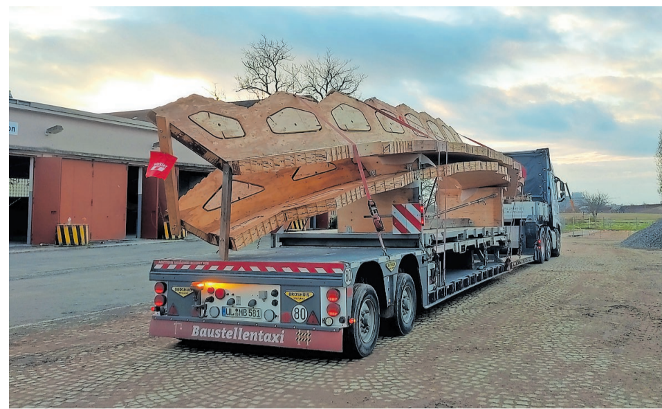
Die Stützbögen des MRN-Pavillons wurden Ende 2022 auf dem Spinellgelände angeliefert. FOTO: BUGA 23
