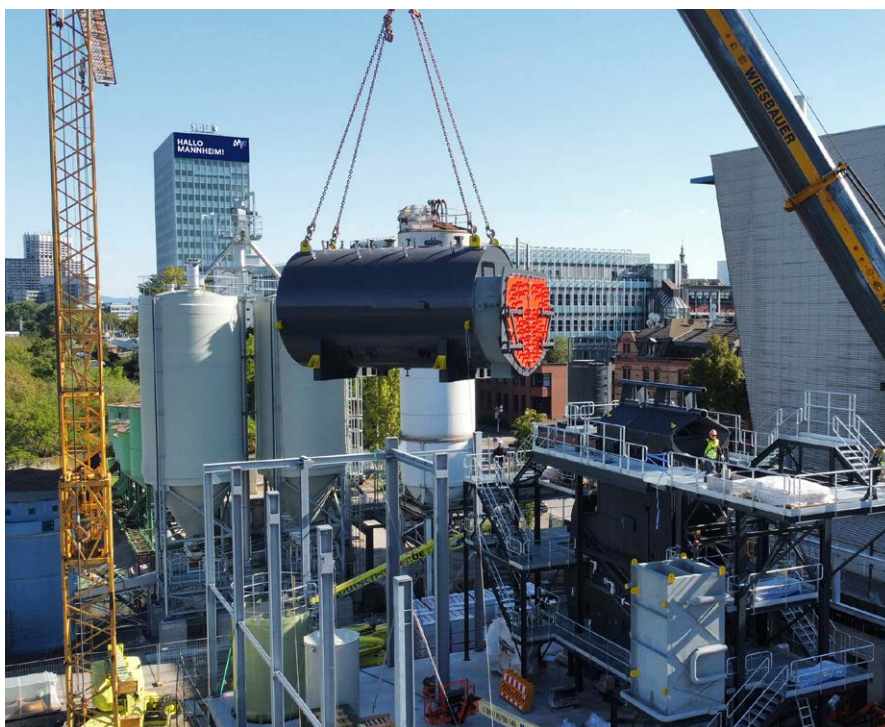
Anlieferung des Biomassekessels für ofi in Mannheim. Autokräne brachten den 25,5 Tonnen schweren und 14,3 Meter hohen Koloss auf der Baustelle in Position.
