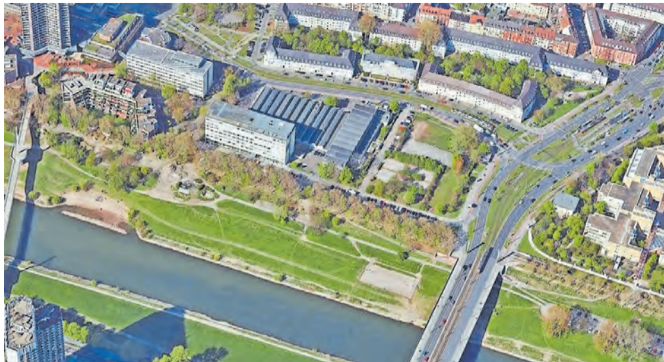
Das bislang unbebaute Grundstück Schafweide liegt zwischen B38, beruflichen Schulen und Neckarwiese und wird städtebaulich weiterentwickelt. FOTO: STADT MANNHEIM
