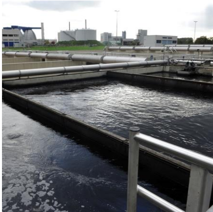
1 Pulveraktivkohleanlage
