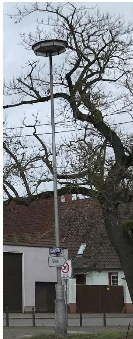
Abbildung 8: Rundumleuchte Typs Vulkan
