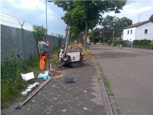
Bild 7: Ansatzpunkt und Bohrarbeiten RKS 4a
