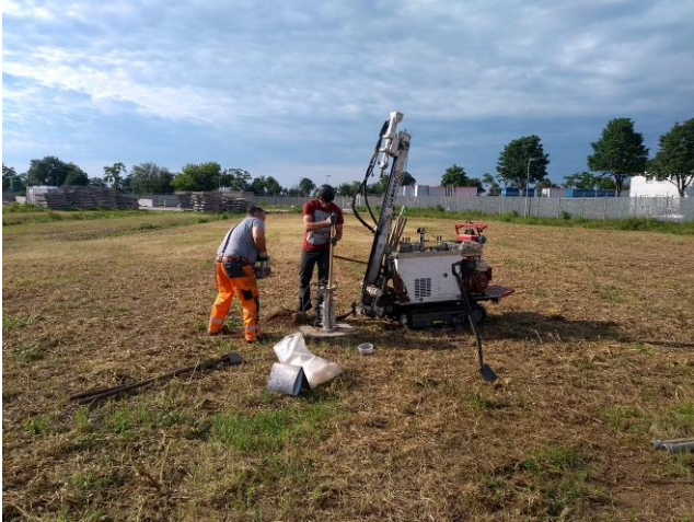
Bild 1: Ansatzpunkt und Bohrarbeiten RKS 1a
