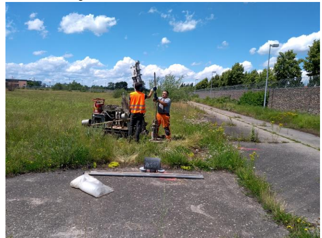
Bild 16: Ansatzpunkt und Bohrarbeiten RKS 10
