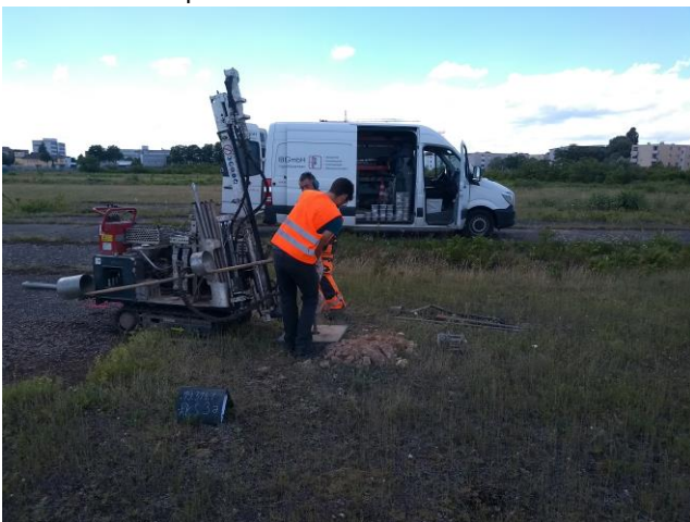
Bild 5: Ansatzpunkt und Bohrarbeiten RKS 3a
