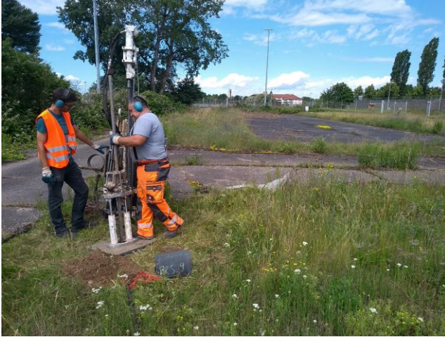
Bild 13: Ansatzpunkt und Bohrarbeiten RKS 9
