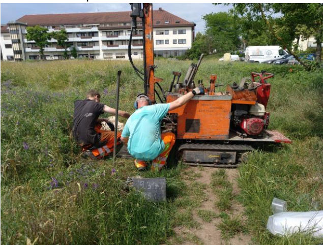
Bild 21: Ansatzpunkt und Bohrarbeiten RKS 15
