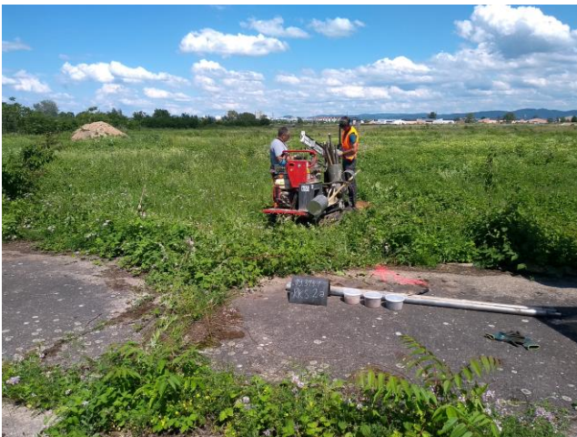
Bild 3: Ansatzpunkt und Bohrarbeiten RKS 2a
