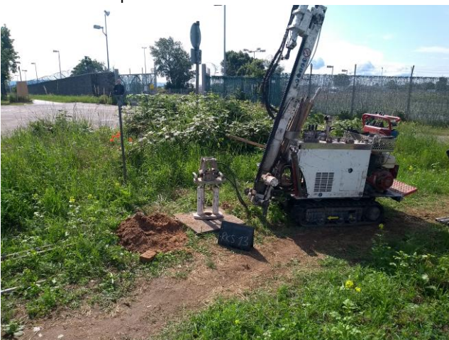
Bild 17: Ansatzpunkt und Bohrarbeiten RKS 13
