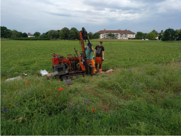
Bild 19: Ansatzpunkt und Bohrarbeiten RKS 14
