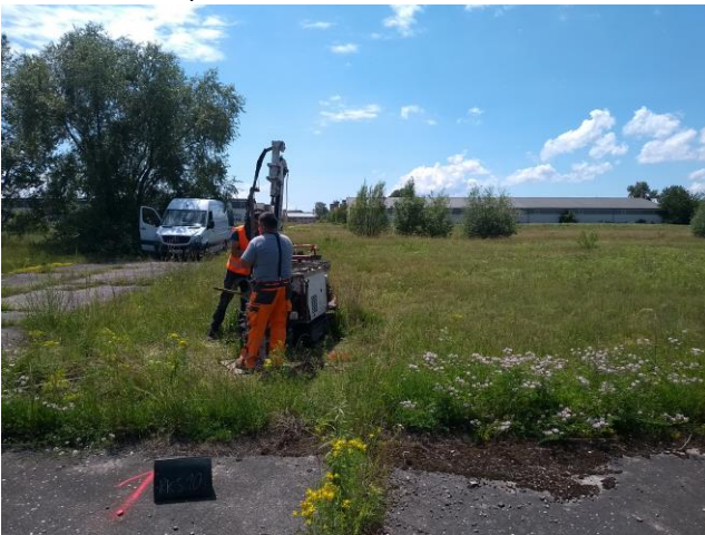
Bild 15: Ansatzpunkt und Bohrarbeiten RKS 10
