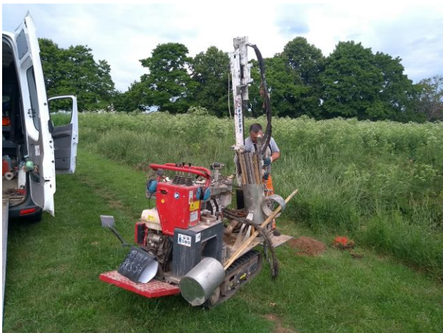
Bild 9: Ansatzpunkt und Bohrarbeiten RKS 5a
