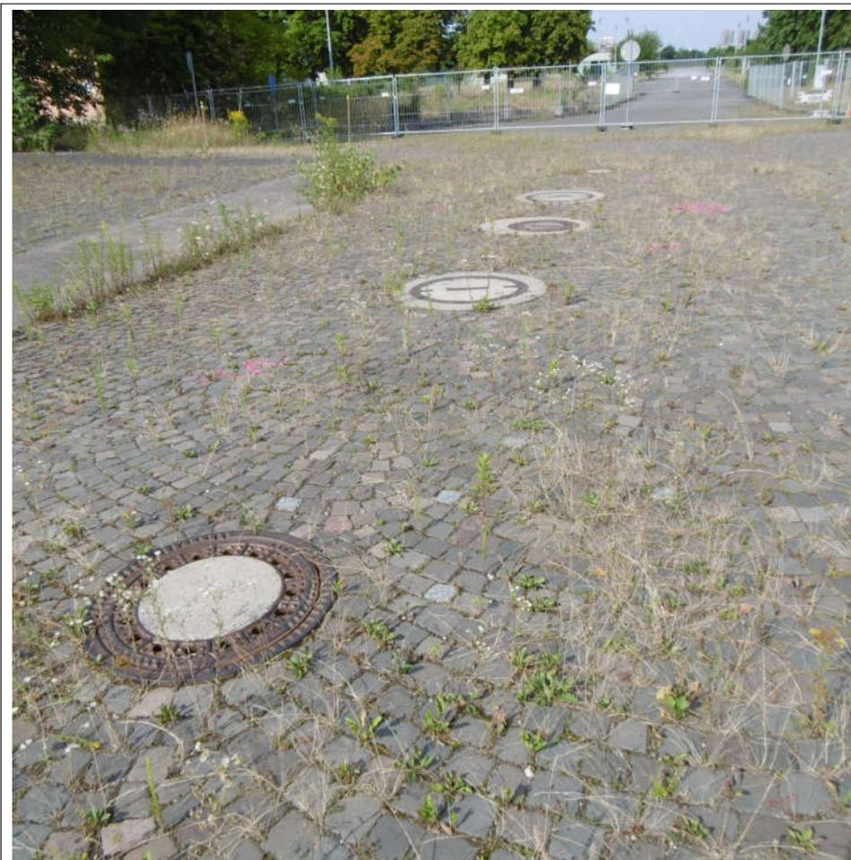
Foto Nr. 36: KVF 38; Leichtflüssigkeitsabscheider (3x),
