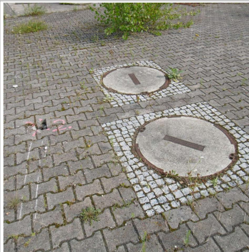
Foto Nr. 71: KVF 71; Leichtflüssigkeitsabscheider (4x),
