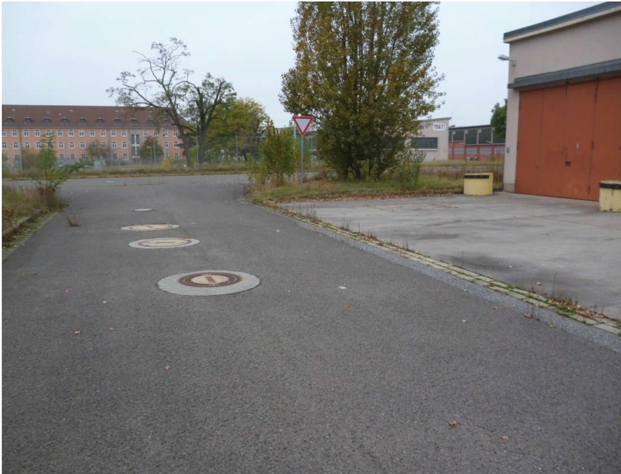
Foto Nr. 20: KVF 27; Leichtflüssigkeitsabscheider, (3x) nördl. Geb.151 [Quelle: Erfassung und Erstbewertung von kontaminationsverdächtigen Flächen (Phase I) ehem. US-Liegenschaft Spinelli-Barracks Feudenheim, CDM Smith, 2015)]
