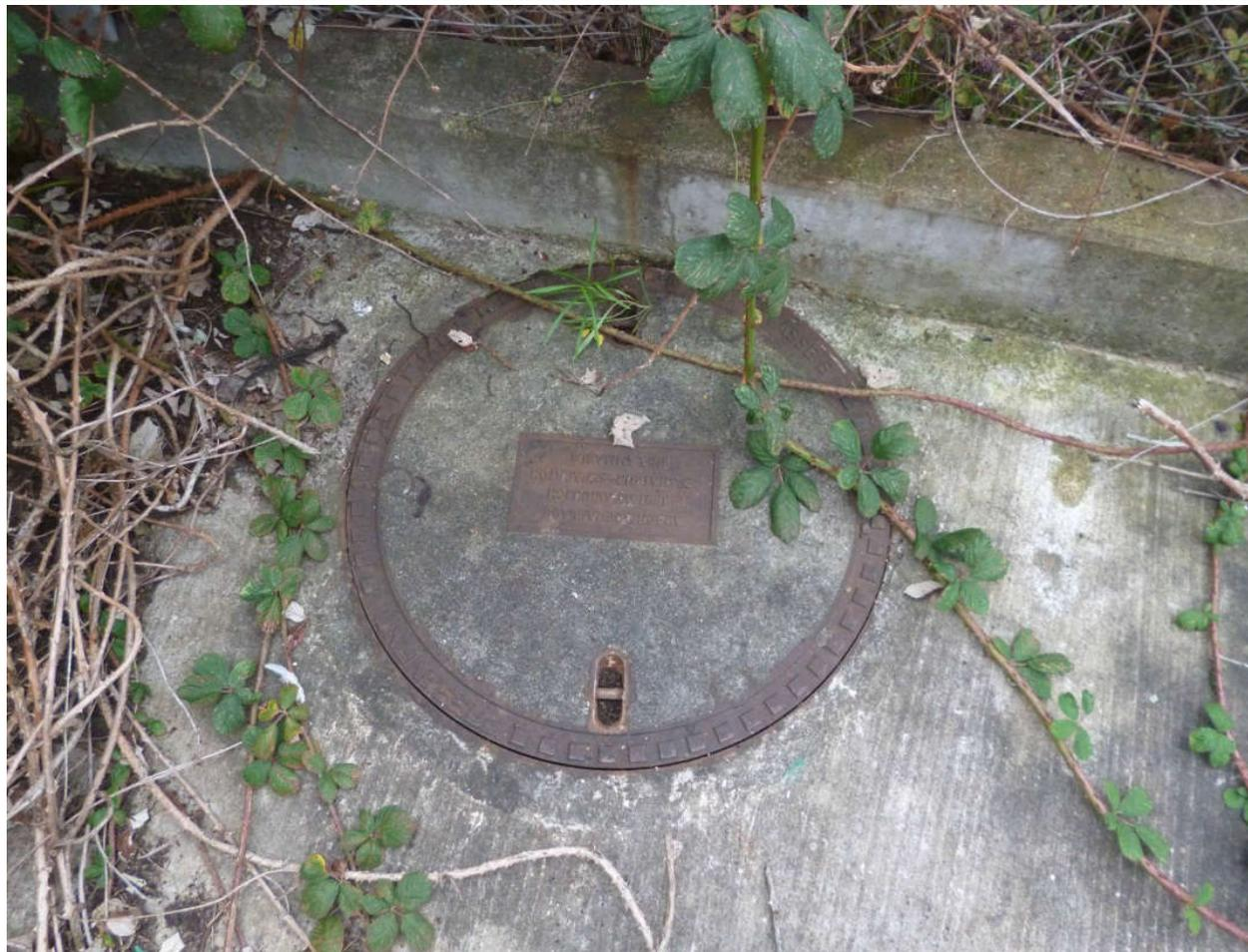
Foto Nr. 96: KVF 118; Leichtflüssigkeitsabscheider (2x), südl. Geb. 1504 [Quelle: Erfassung und Erstbewertung von kontaminationsverdächtigen Flächen (Phase I) ehem. US-Liegenschaft Spinelli-Barracks Feudenheim, CDM Smith, 2015)]
