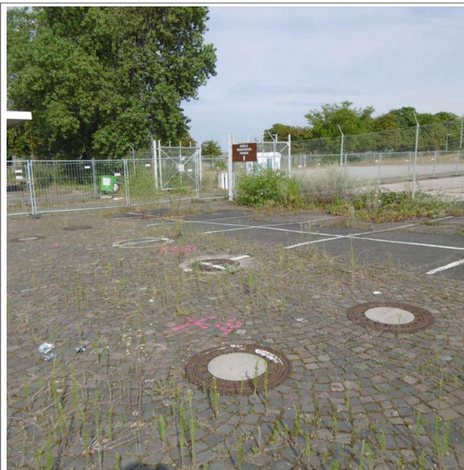
Foto Nr. 40: KVF 41; Leichtflüssigkeitsabscheider (2x),
