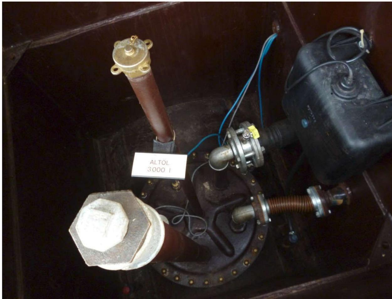
Foto Nr. 16: KVF 20; Altöltank 1/Frostschutzmitteltank, Geb.1577 [Quelle: Erfassung und Erstbewertung von kontaminationsverdächtigen Flächen (Phase I) ehem. US-Liegenschaft Spinelli-Barracks Feudenheim, CDM Smith, 2015)]
