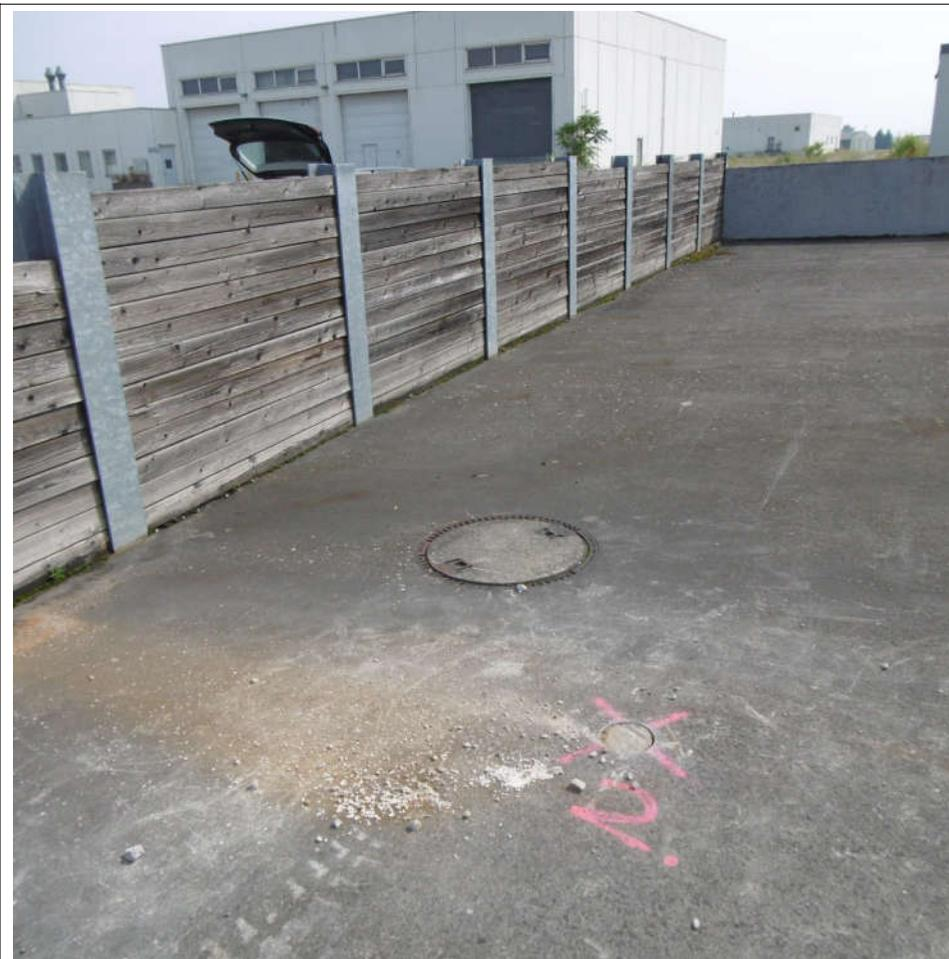
Foto Nr. 63: KVF 66; Waschplatz mit Leichtflüssigkeitsabscheider (2x),
