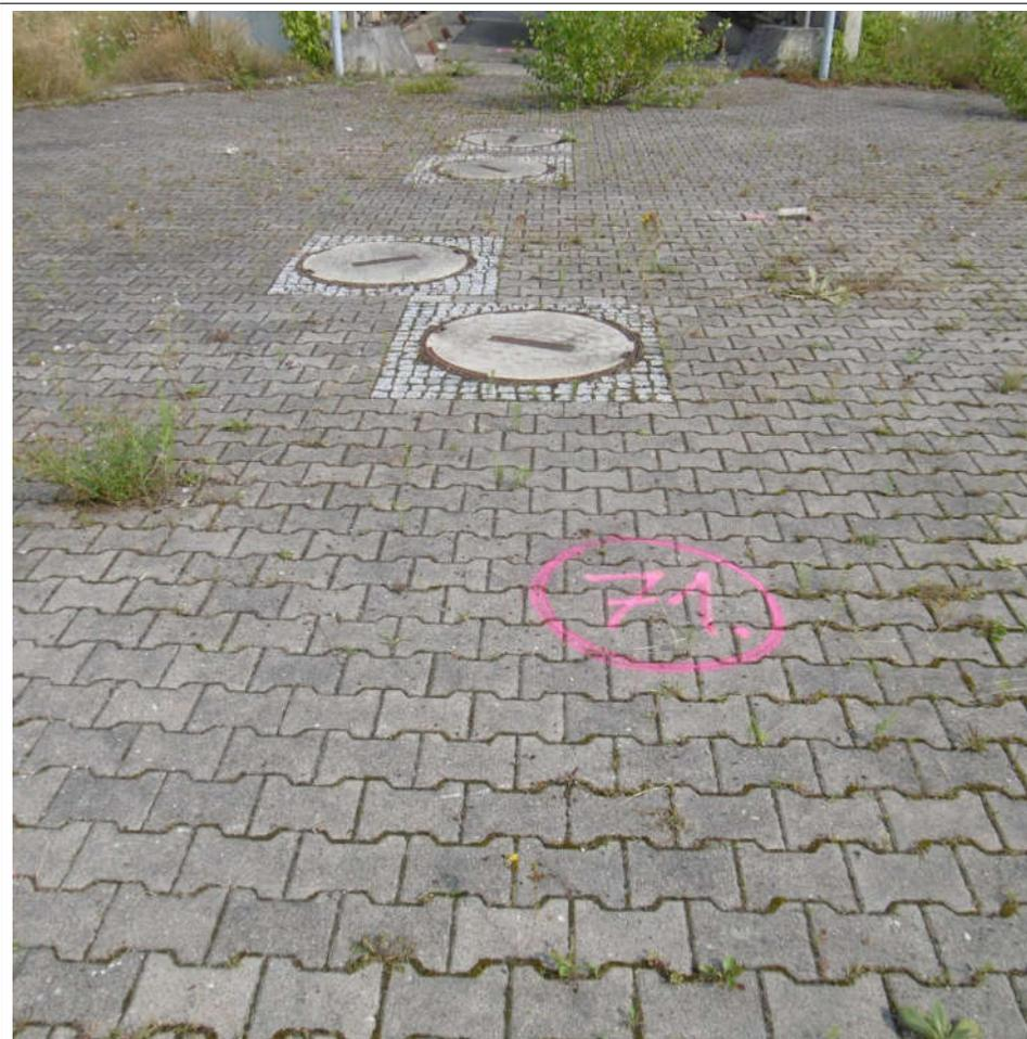
Foto Nr. 70: KVF 71; Leichtflüssigkeitsabscheider (4x),
