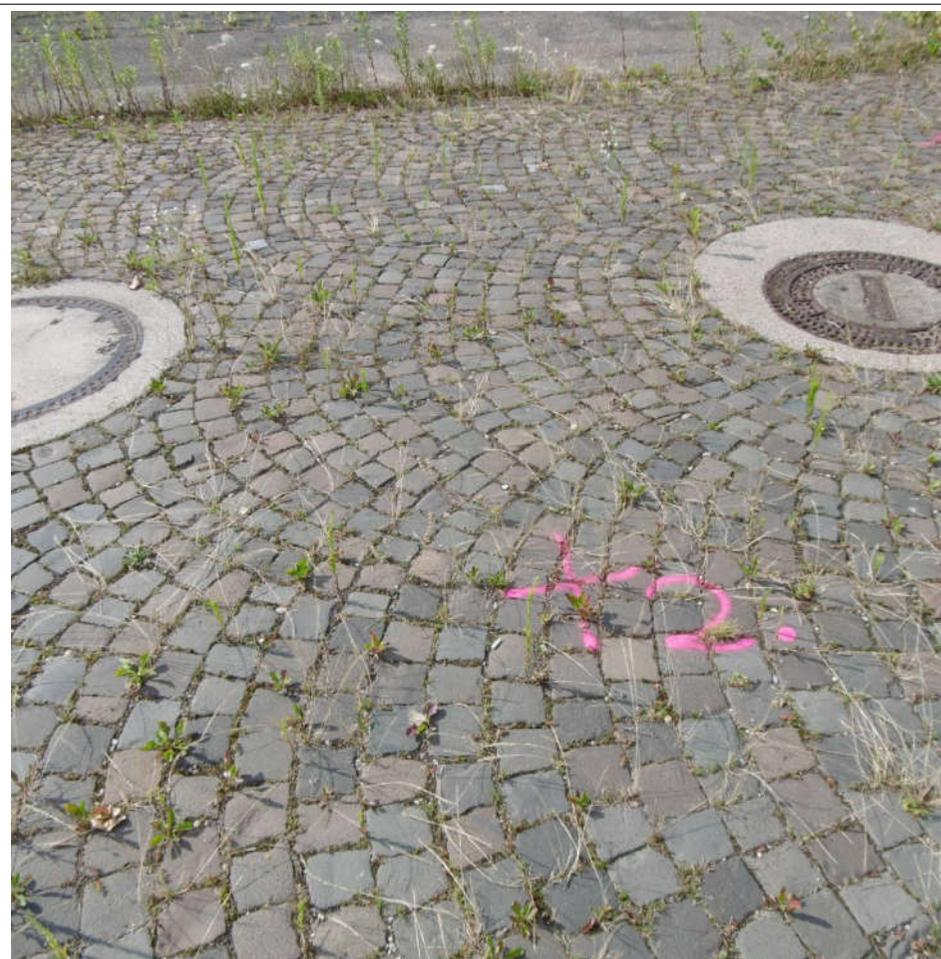
Foto Nr. 37: KVF 38; Leichtflüssigkeitsabscheider (3x),
