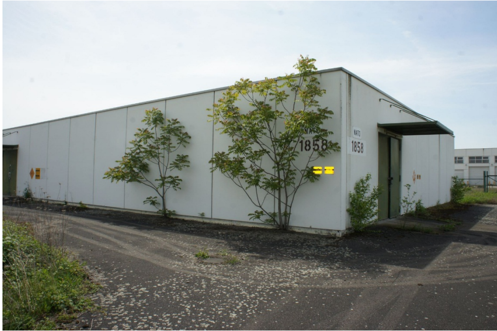
Foto Nr. 43: KVF 87; Lagerhalle Gebäude 1858
