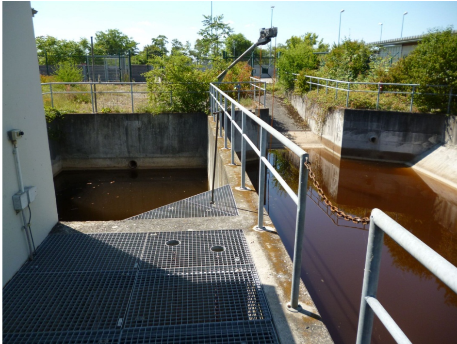
Foto Nr. 29: KVF 73; Abwasserbecken
