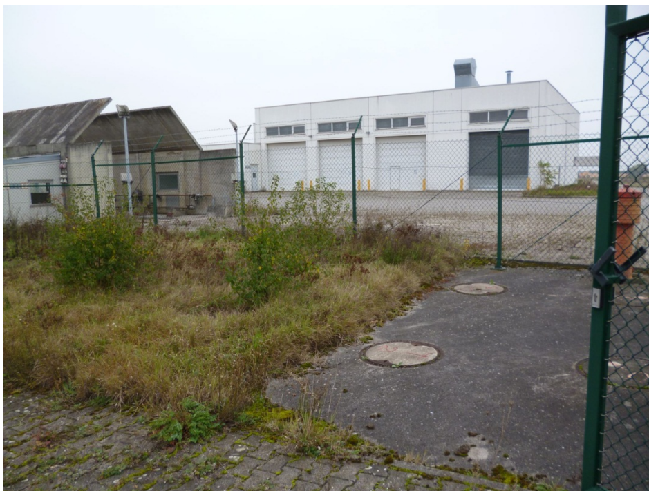
Foto Nr. 26: KVF 70; Leichtflüssigkeitsabscheider (10x) östl. Gebäude 1701
