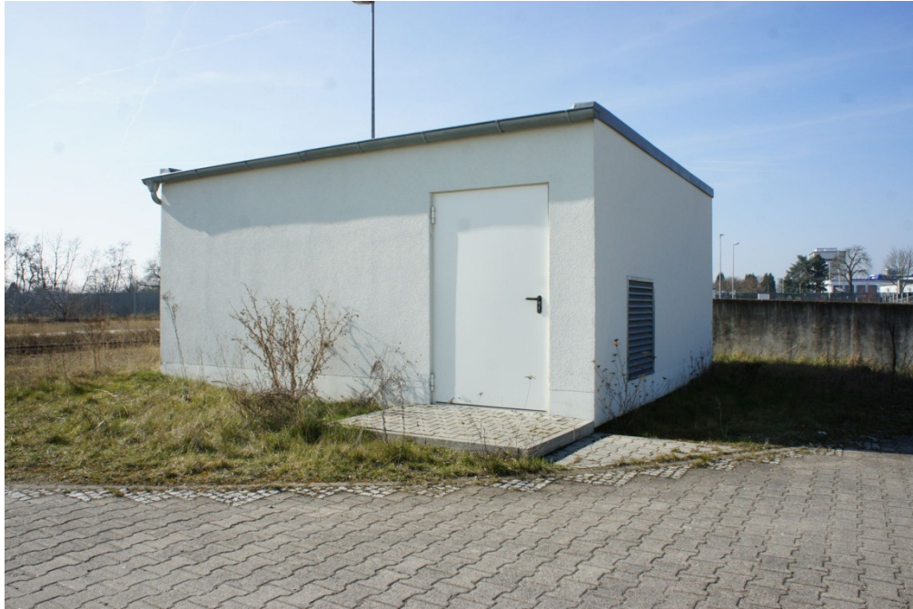
Foto Nr. 23: KVF 67; Kompressor Gebäude 1851
