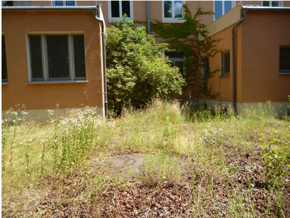
Foto Nr. 7: KVF 51; Leichtflüssigkeitsabscheider (1x) westl. Gebäude 1566
