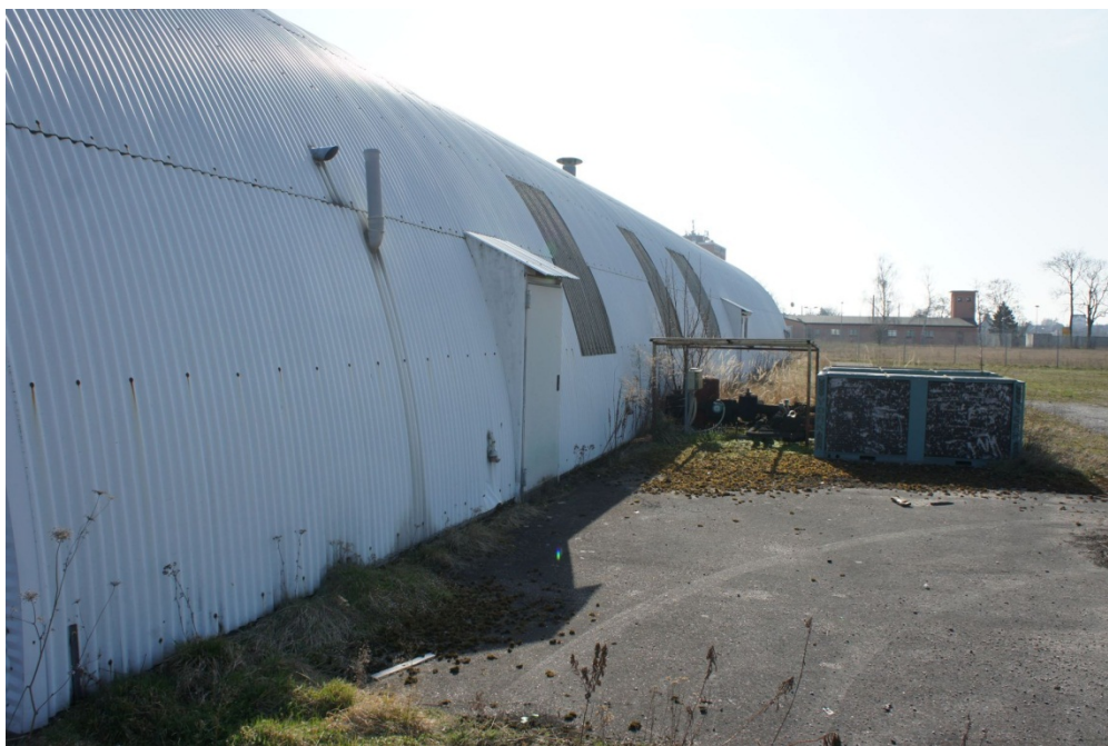
Foto Nr. 10: KVF 54; Kältemittelanlage Gebäude 1677
