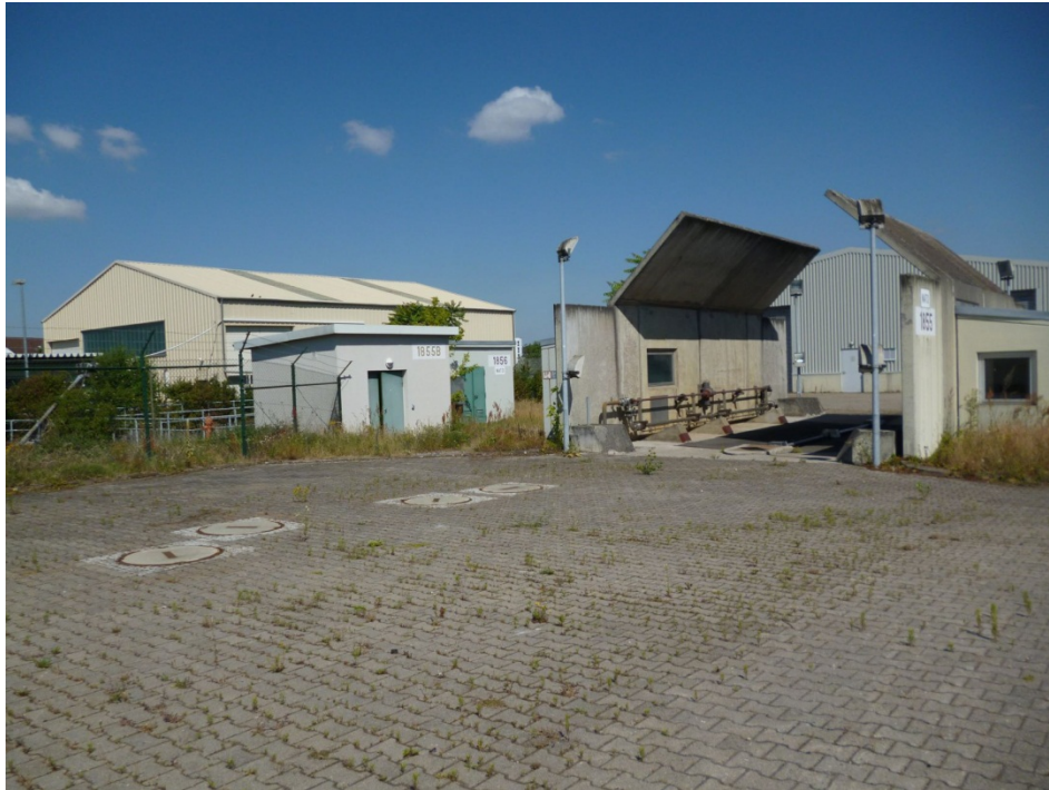
Foto Nr. 27: KVF 71; Leichtflüssigkeitsabscheider (4x) südl. Gebäude 1855
