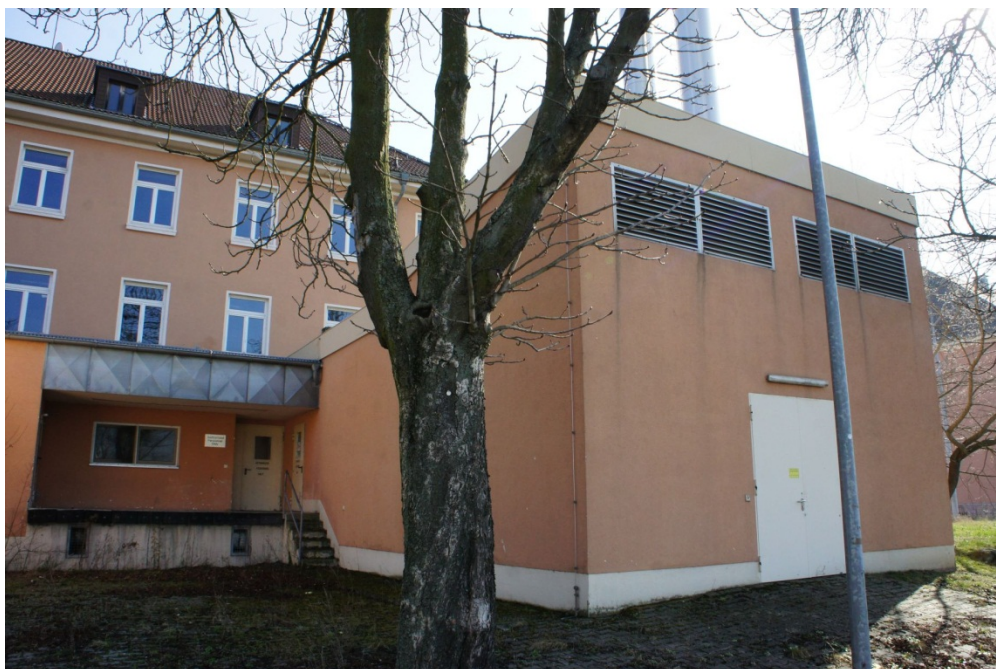
Foto Nr. 8: KVF 52; Technikraum Gebäude 1566
