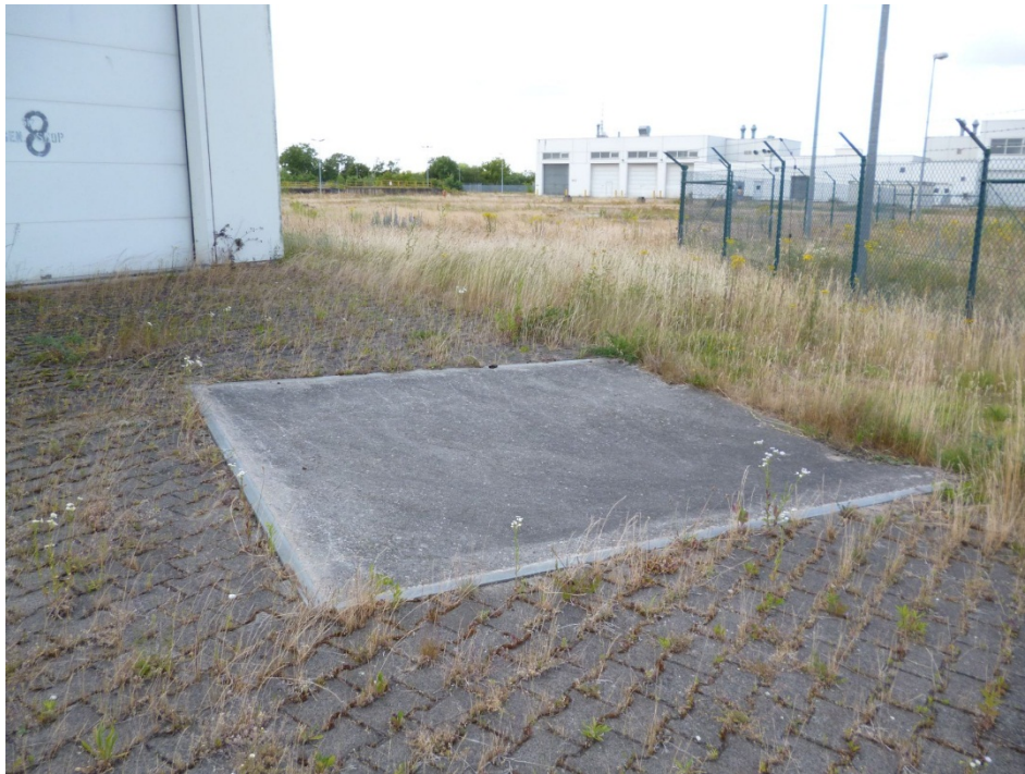
Foto Nr. 44: KVF 88; Tank Gebäude 1857
