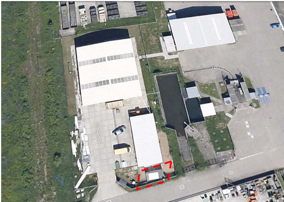
Foto Nr. 24: KVF 68; Heizöltank Gebäude 1701
