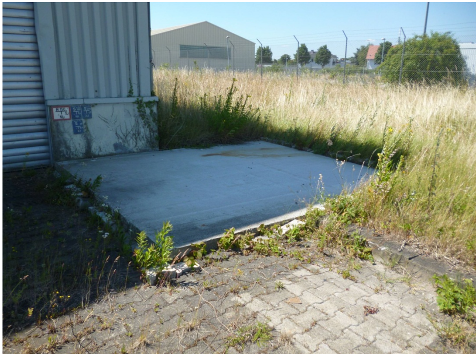
Foto Nr. 36: KVF 80; Heizöltanks Gebäude 1853
