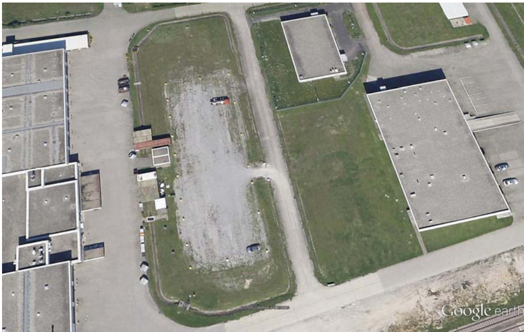
Foto Nr. 42: KVF 86; Kfz-Stellfläche östl. Gebäude 1852 (Google Earth)
