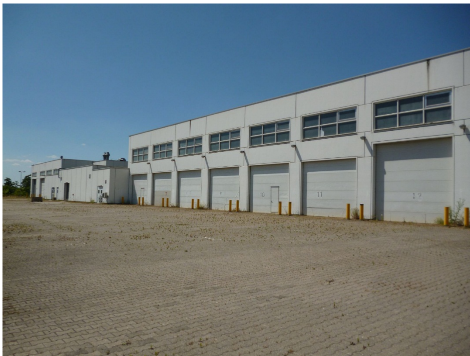
Foto Nr. 39: KVF 83; Motor Pool Gebäude 1852
