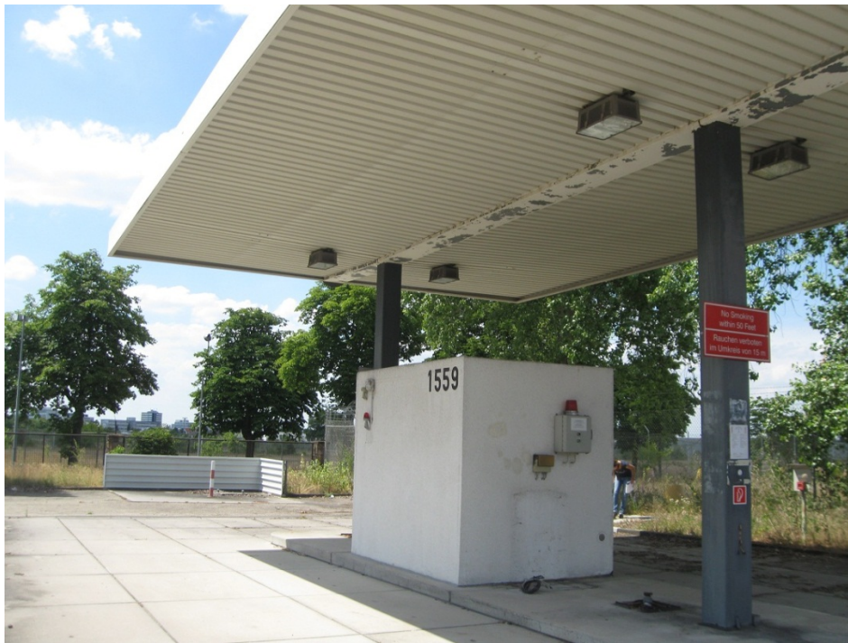
Foto Nr. 5: KVF 49; Tankstelle Gebäude 1559
