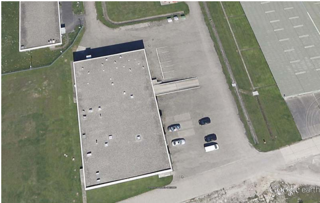
Foto Nr. 45: KVF 89; Kfz-Stellfläche östl. Gebäude 1857 (Google Earth)
