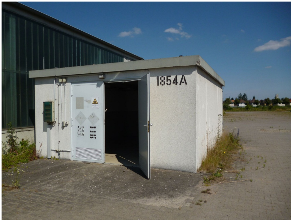
Foto Nr. 33: KVF 77; Gefahrstofflager Gebäude 1854A
