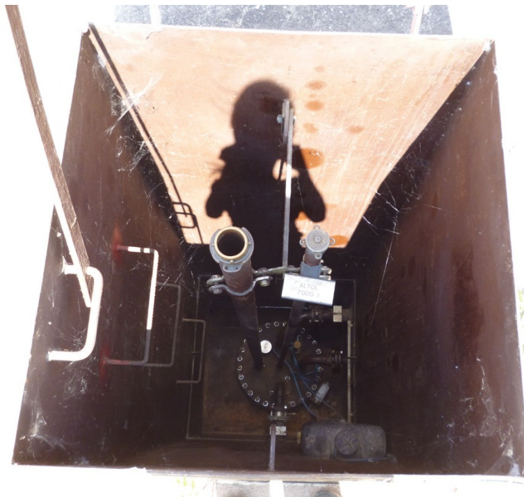
Foto Nr. 46: KVF 90; Altöltank Gebäude 1859
