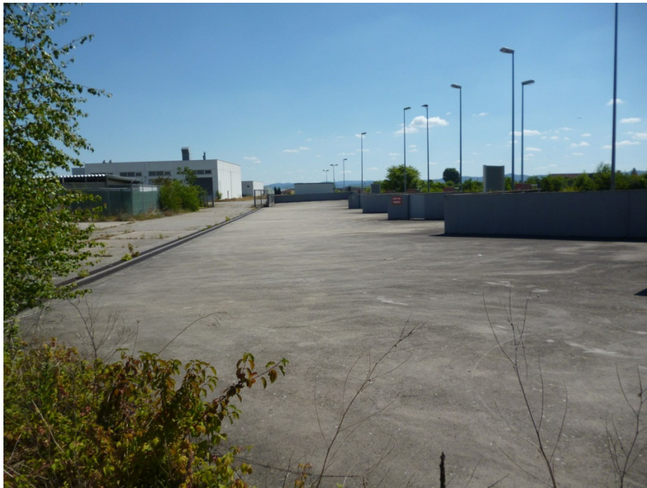
Foto Nr. 22: KVF 66; Waschplatz mit Leichtflüssigkeitsabscheider (2x) südl. Gebäude 1855B
