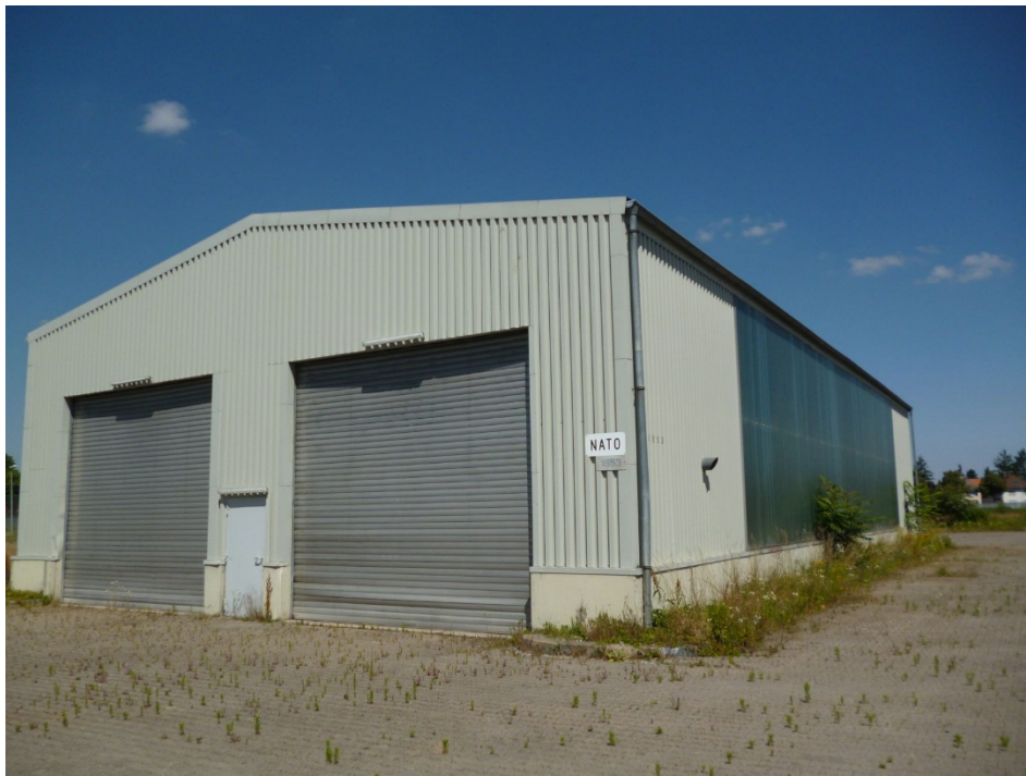
Foto Nr. 35: KVF 79; Werkstatthalle Gebäude 1853
