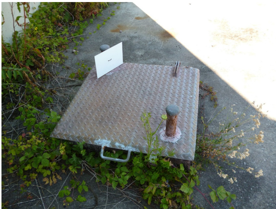
Foto Nr. 34: KVF 78; Altöltank Gebäude 1853
