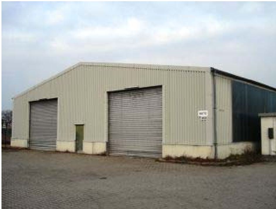
Foto Nr. 32: KVF 76, Werkstatthalle Gebäude 1854
