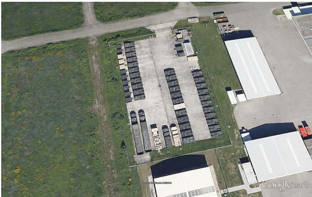
Foto Nr. 38: KVF 82; Kfz-Stellfläche westl. Gebäude 1853 (Google Earth)
