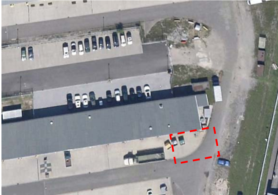
Foto Nr. 23: KVF 23; Altöltank Gebäude 1572 (Google Earth)
