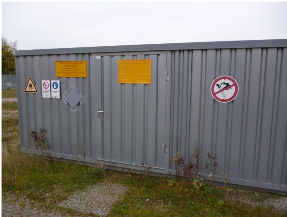
Foto Nr. 19: KVF 19; Gefahrstofflager nördl. Gebäude 1578
