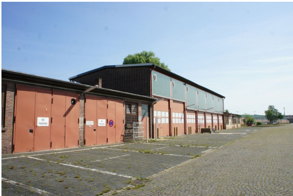
Foto Nr. 42: KVF 42; Werkstatthalle, Gefahrstofflager Gebäude 1563
