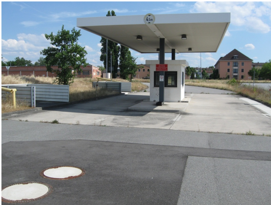
Foto Nr. 17: KVF 17; Tankstelle Gebäude 1576
