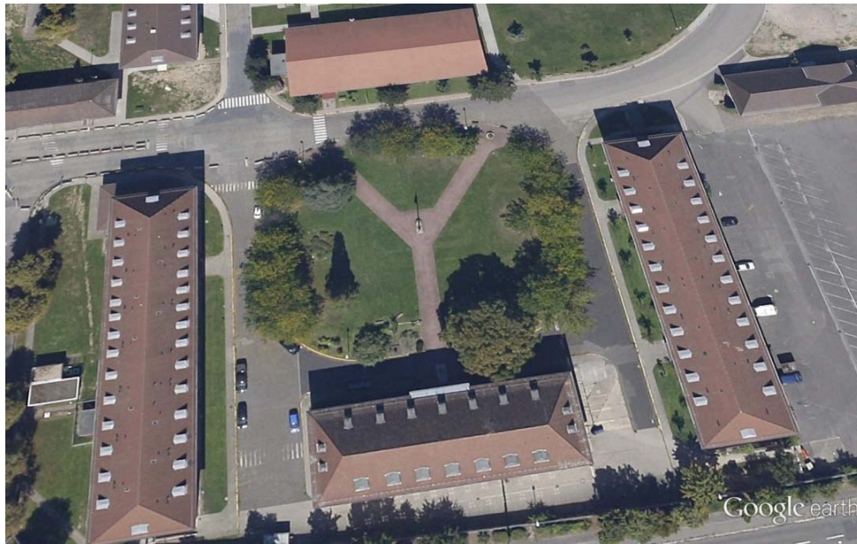
Foto Nr. 15: KVF 15; Löschwasserbecken Süd (Google Earth)
