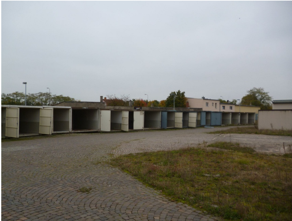
Foto Nr. 29: KVF 29; Fertigteilgaragen Ost
