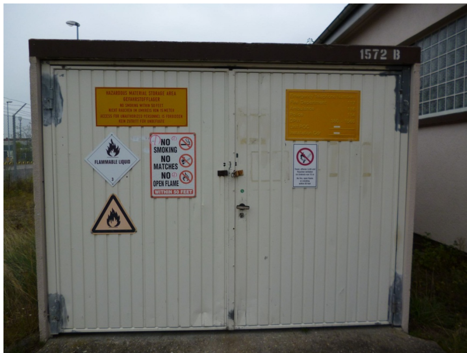
Foto Nr. 24: KVF 24; Tanklager Gebäude 1572B
