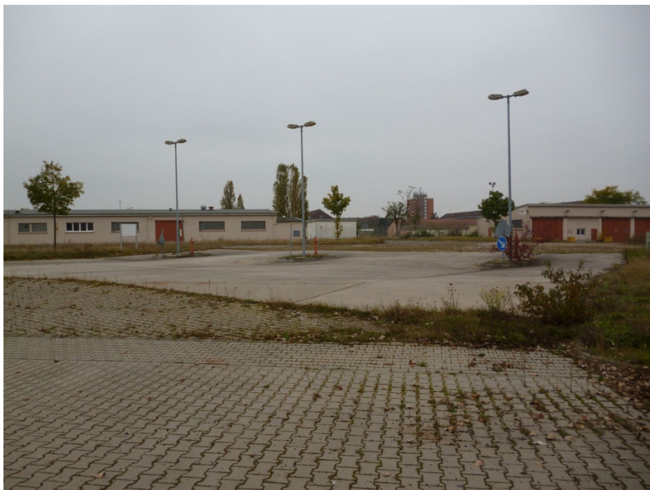
Foto Nr. 34: KVF 34; Waschplatz südl. Gebäude 1560
