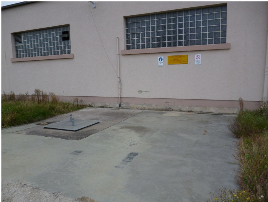
Foto Nr. 21: KVF 21; Altöltank 2 Gebäude 1577
