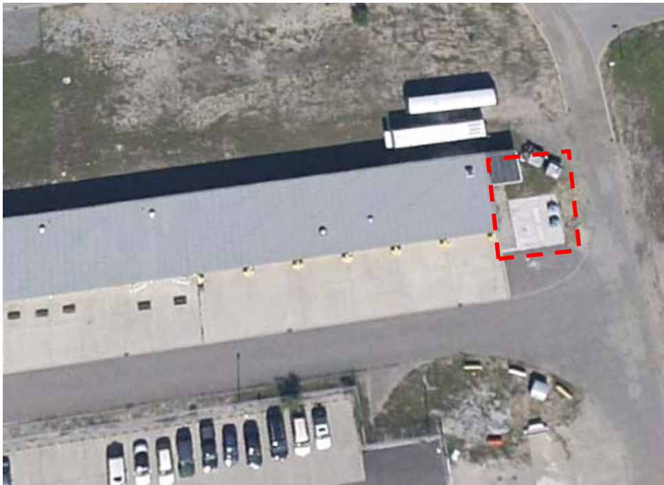
Foto Nr. 30: KVF 30, Frostschutzmitteltank östl. Gebäude 1570 (Google Earth)
