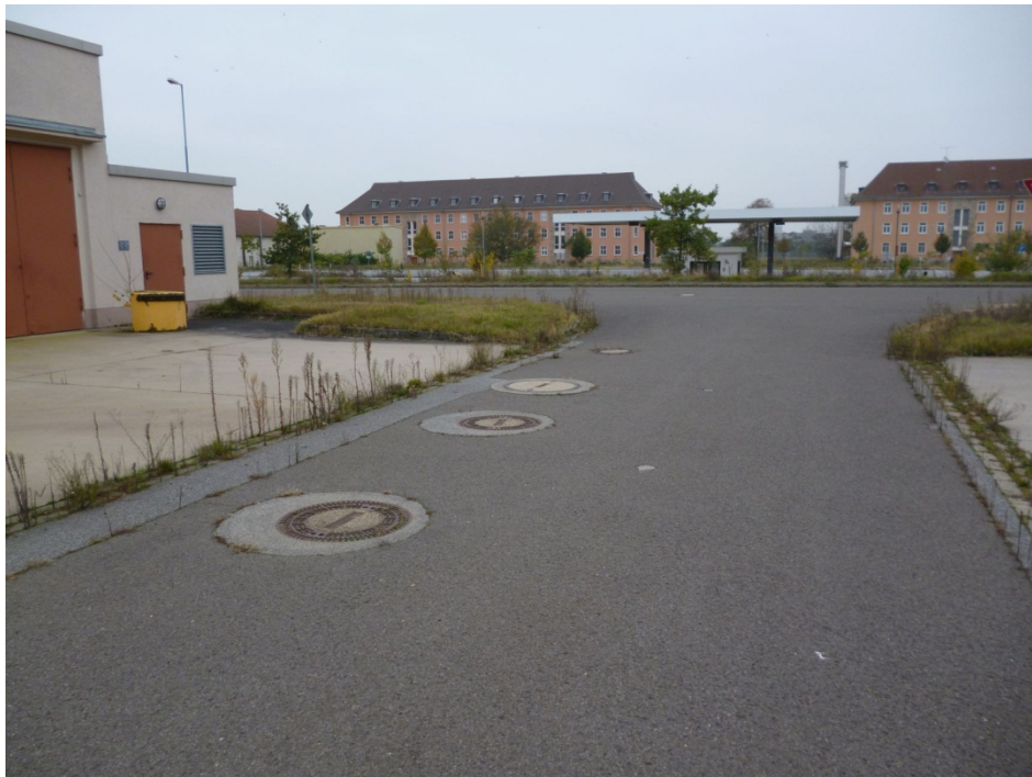
Foto Nr. 22: KVF 22; Leichtflüssigkeitsabscheider (3x) nördl. Gebäude 1577
