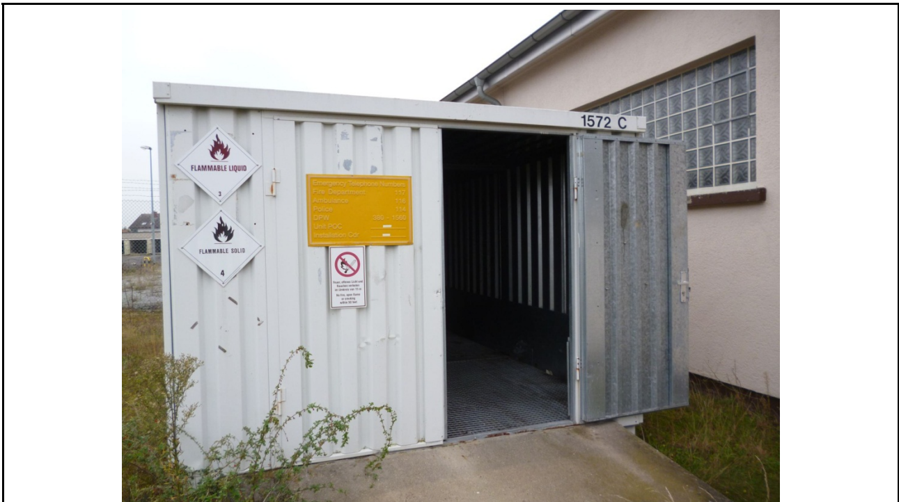
Foto Nr. 25: KVF 25; Gefahrstofflager Gebäude 1572C
