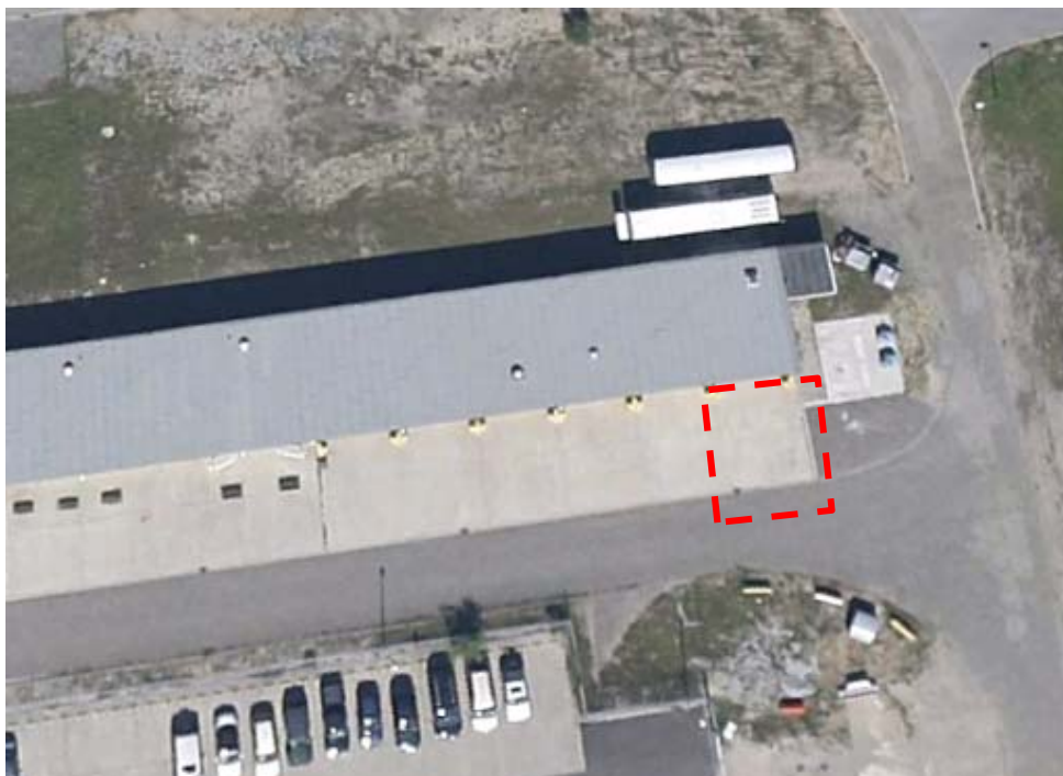
Foto Nr. 28: KVF 28; Altöltank Gebäude 1570 (Google Earth)
