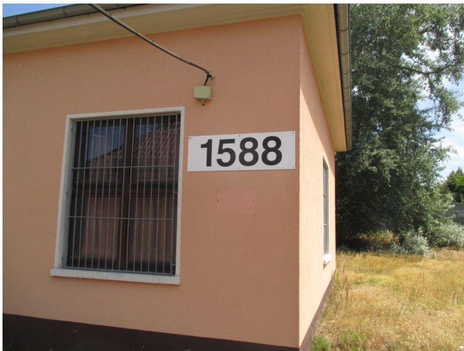
Foto Nr. 8: KVF 8; Trafostation (vermutet) Gebäude 1588
