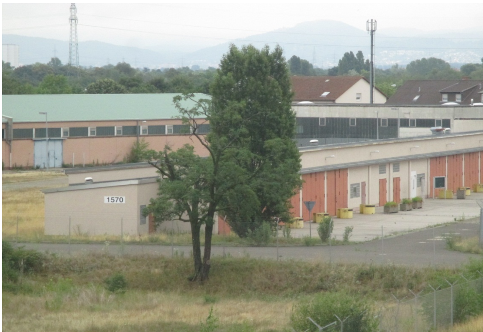
Foto Nr. 2: KVF 2; Kfz-Halle Gebäude 1570
