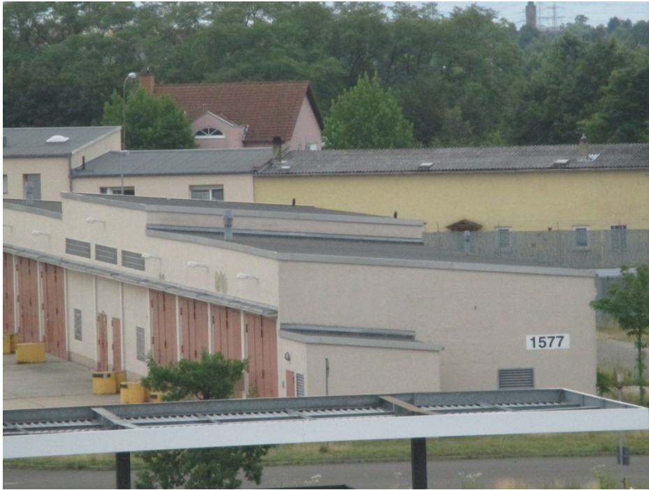
Foto Nr. 5: KVF 5; Kfz-Halle Gebäude 1577
