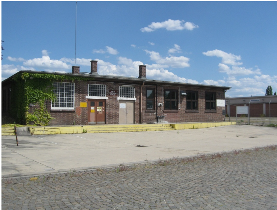
Foto Nr. 44: KVF 44; Kfz-Stellfläche/Waschplatz, Montagegrube westl. Gebäude 1563
