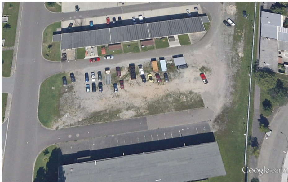
Foto Nr. 6: KVF 6; Kfz-Stellfläche ehem. Kfz-Halle Gebäude 1578 (Google Earth)
