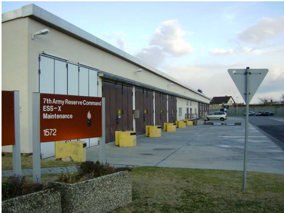
Foto Nr. 4: KVF 4; Kfz-Halle Gebäude 1572
