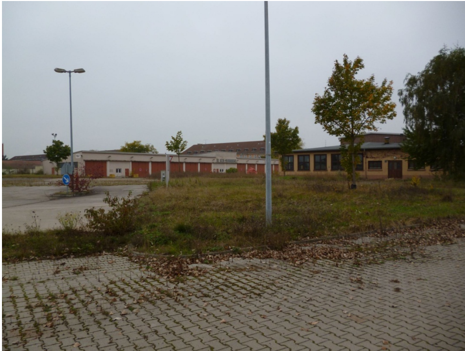
Foto Nr. 35: KVF 35; Löschwasserbecken Nord
