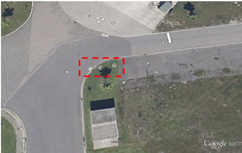
Foto Nr. 32: KVF 32; Leichtflüssigkeitsabscheider (3x) nördl. Gebäude 1569A (Google Earth)
