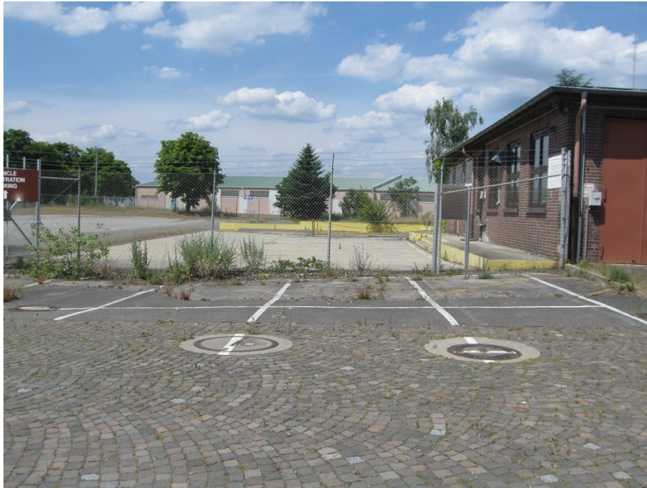
Foto Nr. 41: KVF 41; Leichtflüssigkeitsabscheider (2x) südl. Gebäude 1563
