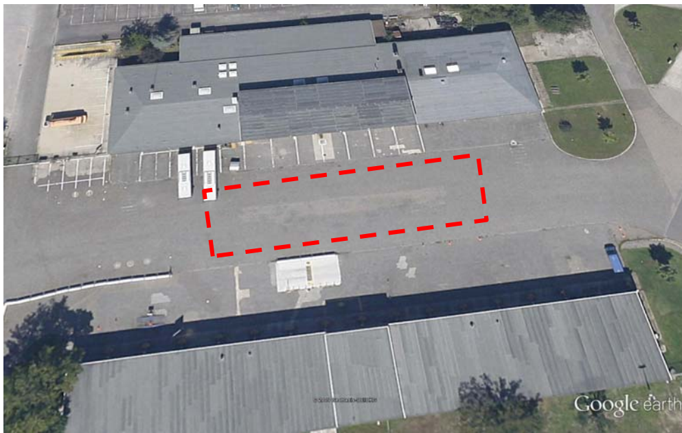
Foto Nr. 39: KVF 39; ehem. Tankstelle Pionierkaserne nördl. Geb. 1567 (Google Earth)
