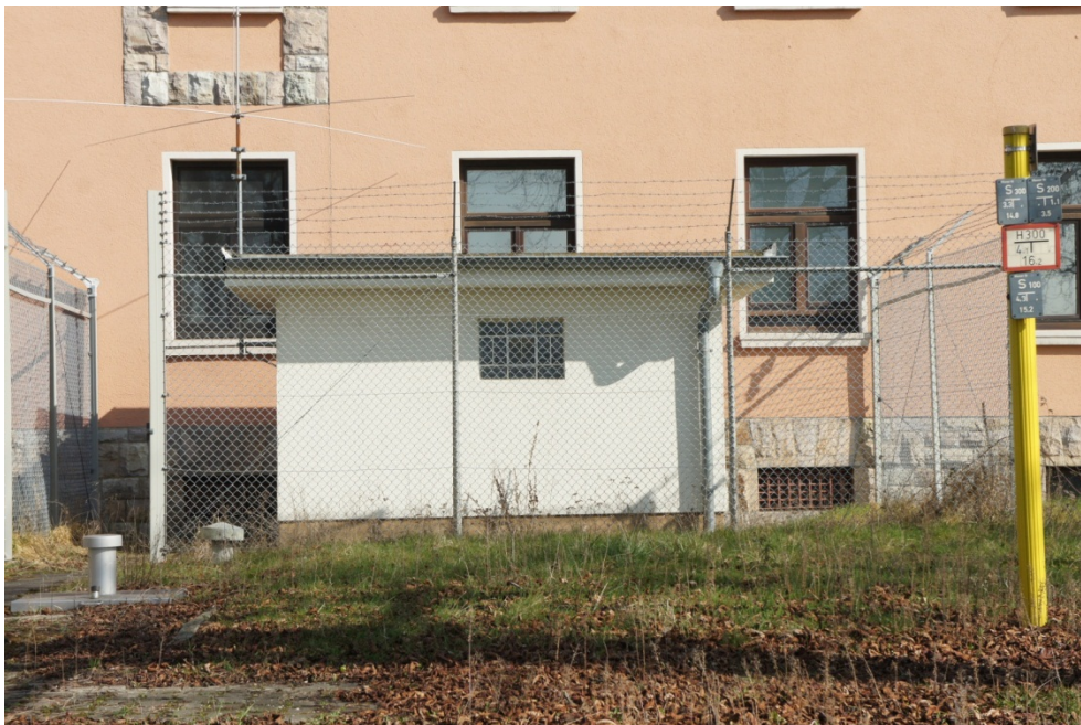
Foto Nr. 10: KVF 10; Chlorstation Gebäude 1541
