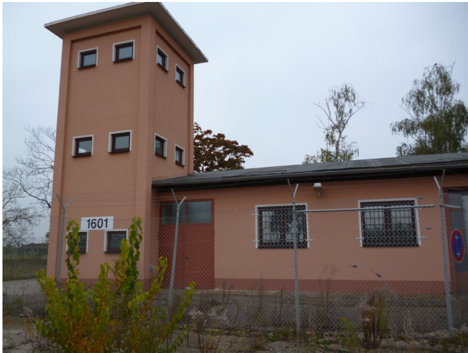
Foto Nr. 12: KVF 12; Feuerwache Gebäude 1601
