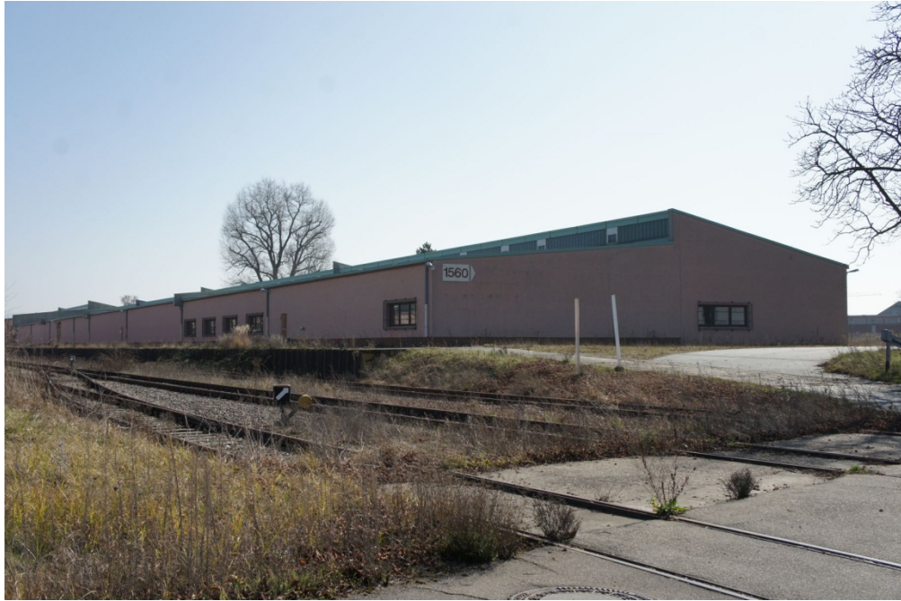
Foto Nr. 1: KVF 1; Kfz-Halle Gebäude 1560
