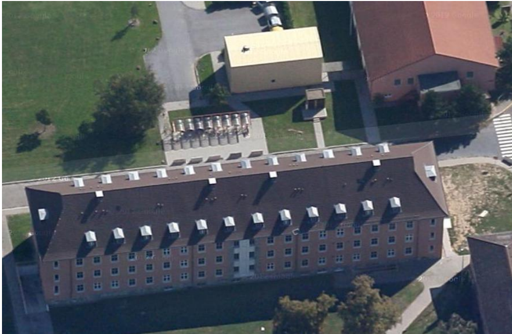
Gebäudetyp, 1-, 2-geschossig (Geb. Nr.: 1601, 1579)
