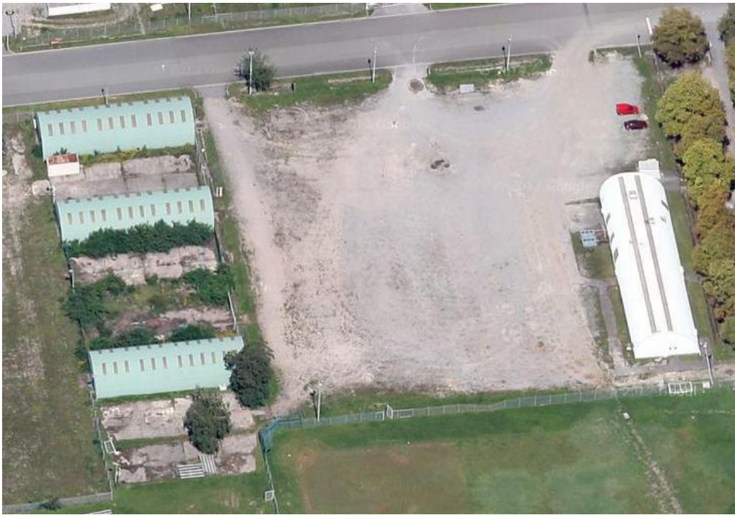
Gebäudetyp, Hallen (Geb. Nr.: 1609, 1607, 1604)
