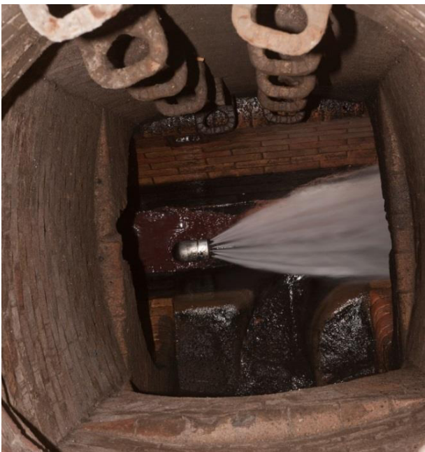
Abb. 33: Spüldüse im Kanal [Foto: EBS, 2012]
