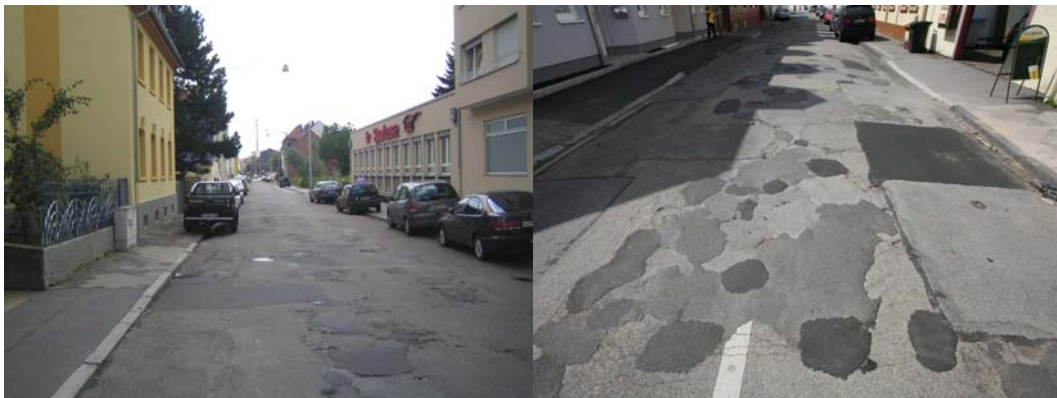
Abbildung 37: Schadhafte Straßenbeläge im Untersuchungsgebiet (Quelle: Fotodokumentation)
