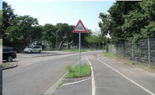
abruptes Ende RV-Anlage nördliche Birkenauer Str.
