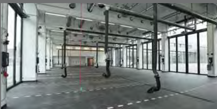
Alarmfahrzeughalle mit Abgasabsaugung und RettboxAir-Anschlüssen
