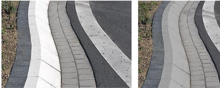
**Abb. 5: Referenz Schrammbord mit Rinne und Fahrbahn mit Oberflächengestaltung Asphalt, wie für die neue Zufahrt vorgesehen. Die Schrammborde bilden auch bei den Verkehrsflächen ein durchgängiges funktionales Gestaltungselement. Foto:**<http://www.meudt-betonsteinwerk.de/referenzobjekte-bordsteinsysteme.html> vom 07.04.2017.
