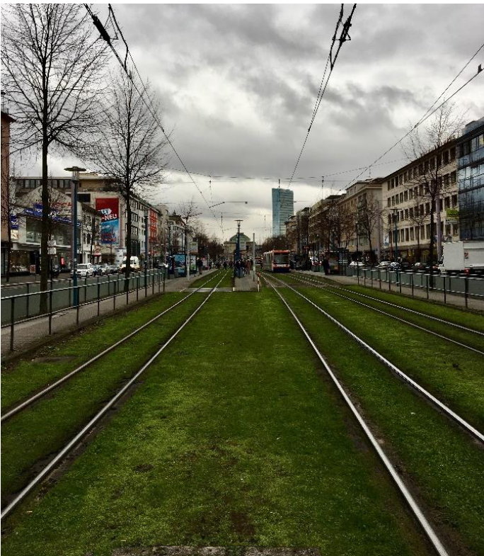
Rasengleis an der Straßenbahnhaltestelle Kunsthalle Mannheim [Foto: Kaiser]
